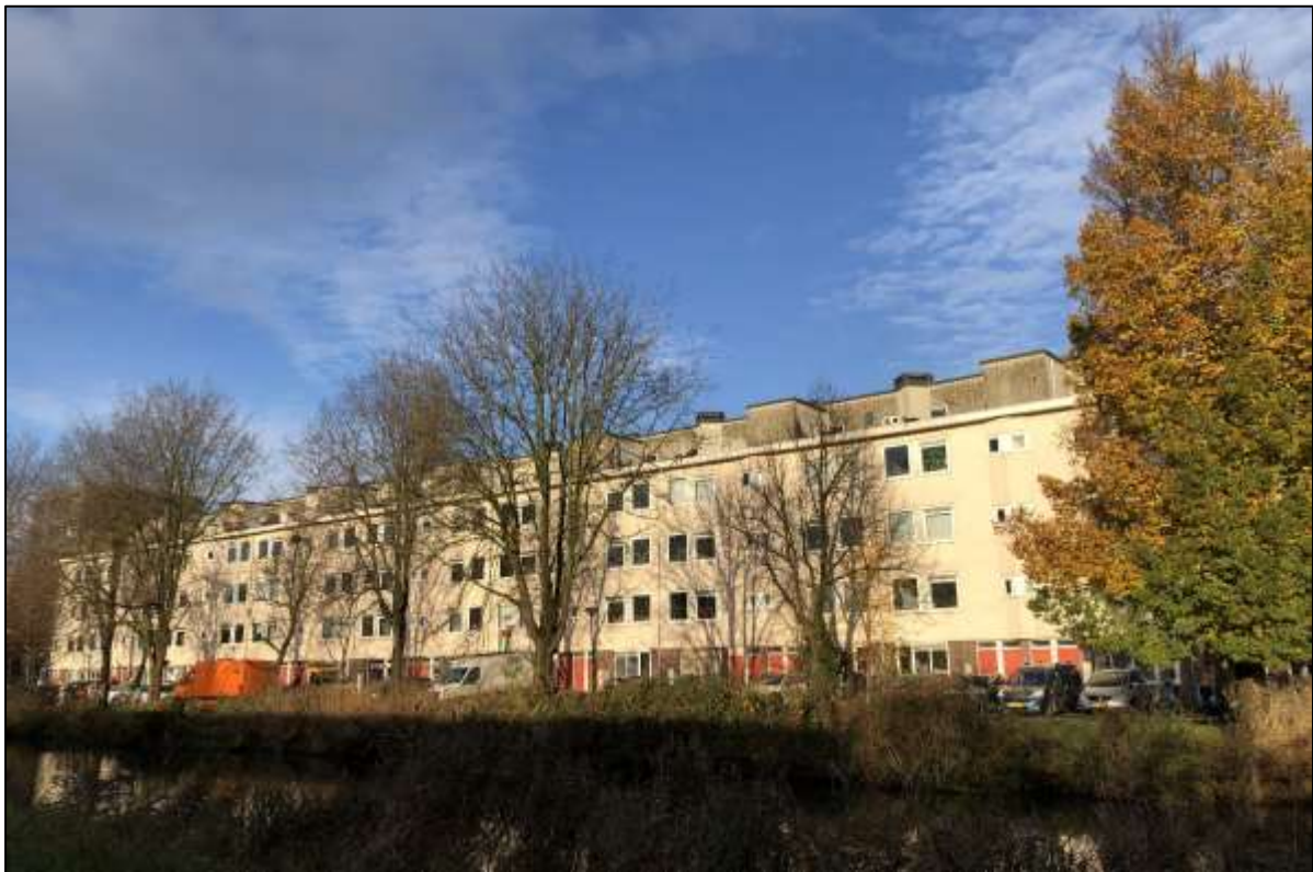
Afbeelding: de bebouwing op de projectlocatie met de van de straat terugliggende vijfde bouwlaag
