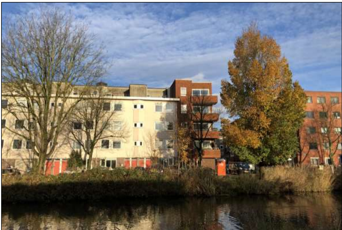
Afbeelding: een deel van de bebouwing op de projectlocatie met daarnaast een deel van de vijflaagse woonbebouwing aan de Ombilinstraat
