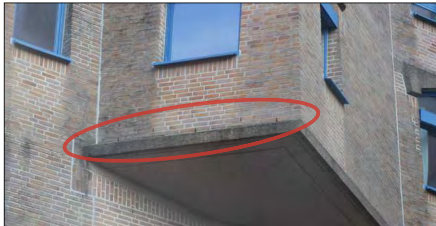
Figuur: Open stootvoegen buiten het plangebied, hierdoor kunnen (gebouwbewonende) vleermuissoorten de spouwmuur van de bebouwing betreden en benutten als verblijfslocatie.
