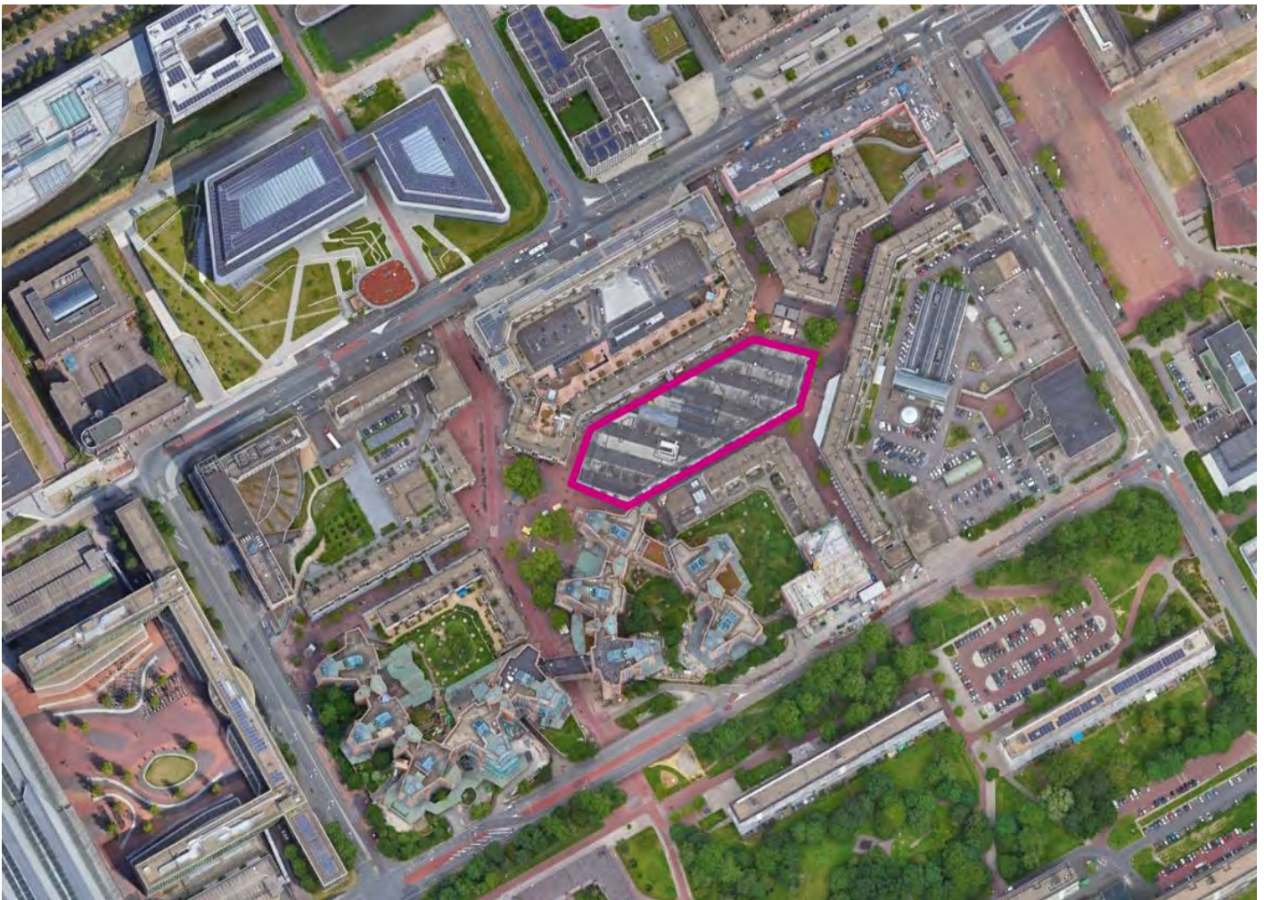
Figuur 1.1 Ligging projectlocatie Cluster 8 in de Amsterdamse Poort (ondergrond: Google Earth; bewerking Rho)
