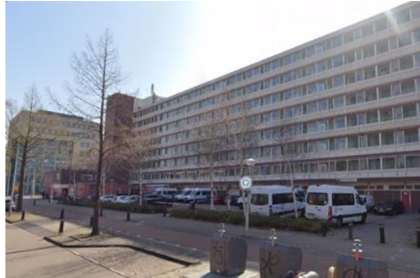
Figuur 2.1 Aanzicht vanuit noorden (bron: Google Streetview)
