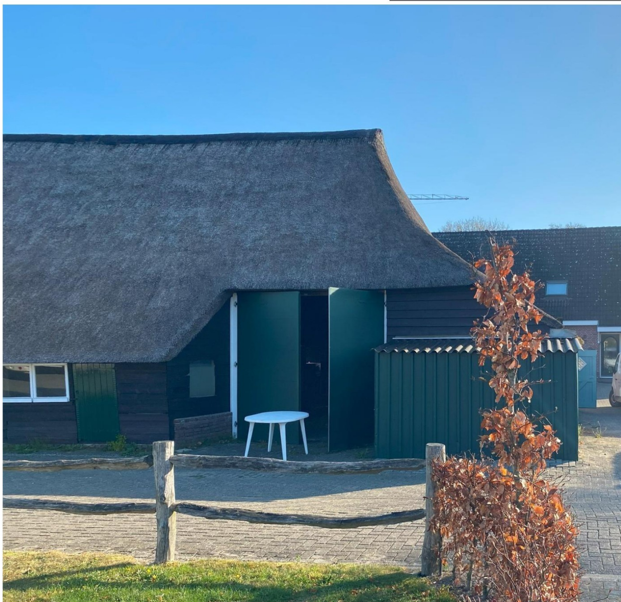
Sandwichpanelen baanderdeur en aanbouw
