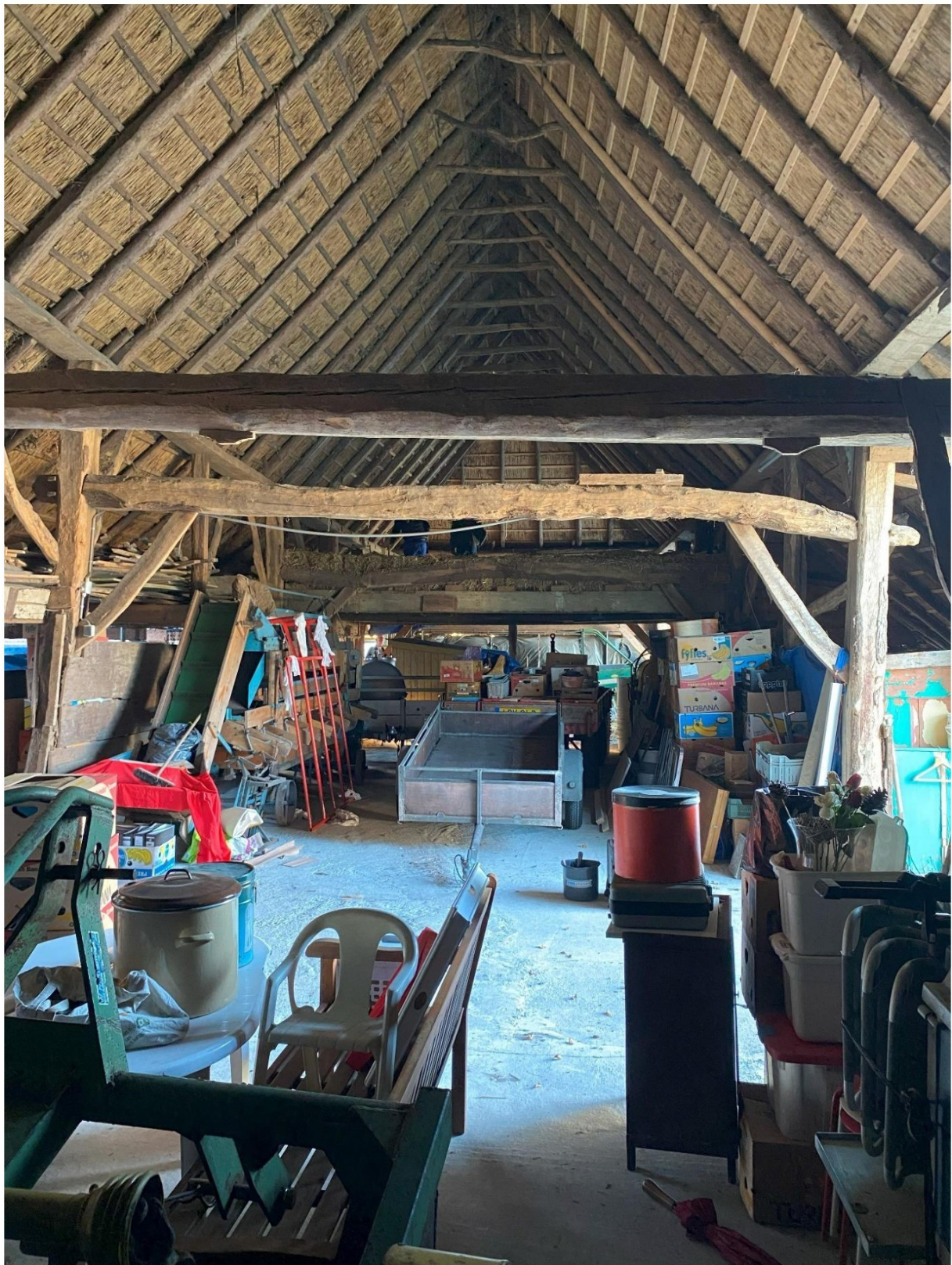
Binnenzijde achterhuis: De oorspronkelijke gebintconstructie en sporenkap
