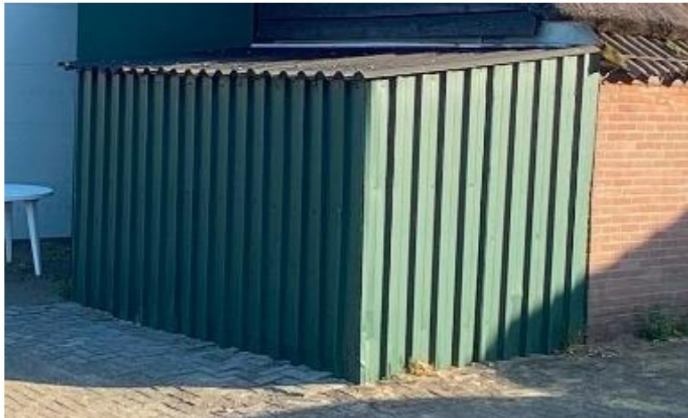
Aanbouw aan de linkerzijde van de gevel verwijderen.
