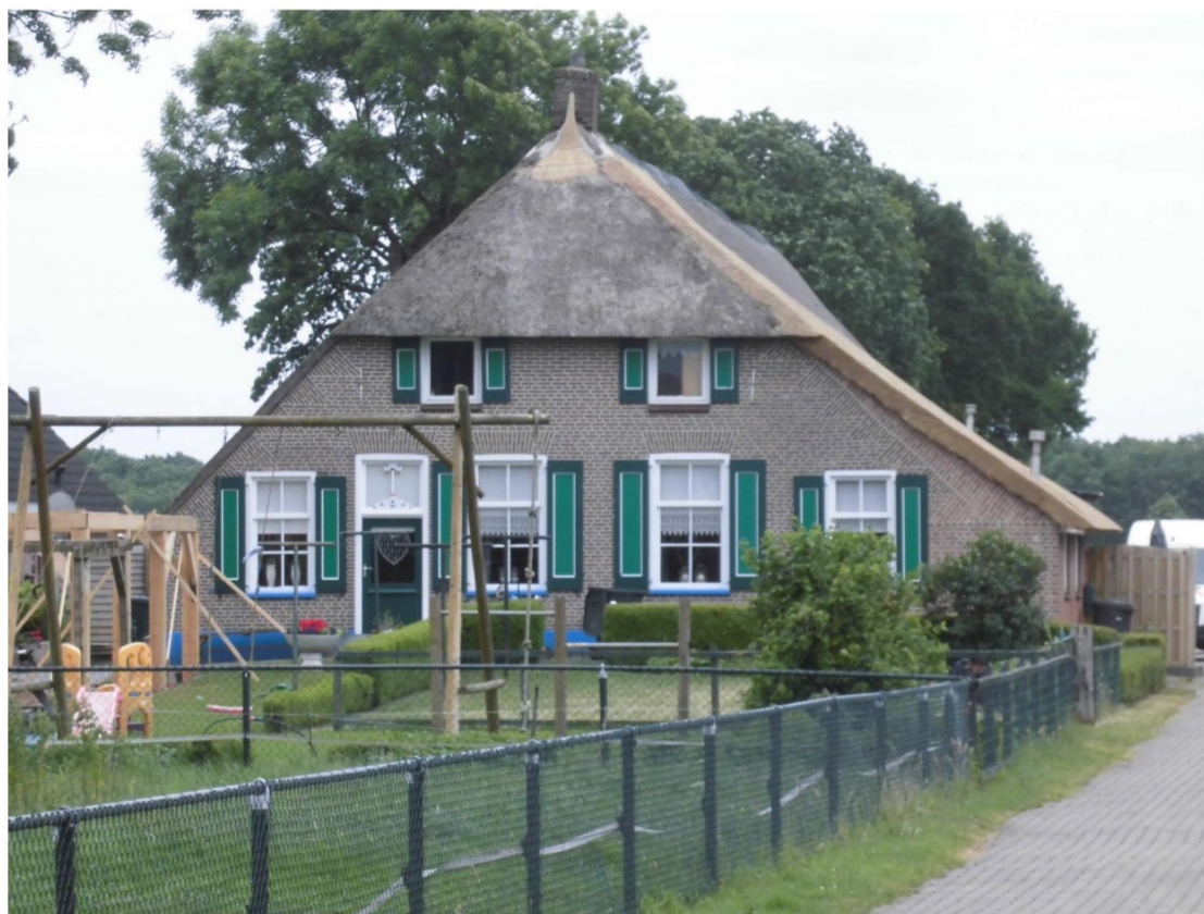
Voorgevel van Oude Rijksweg 99
