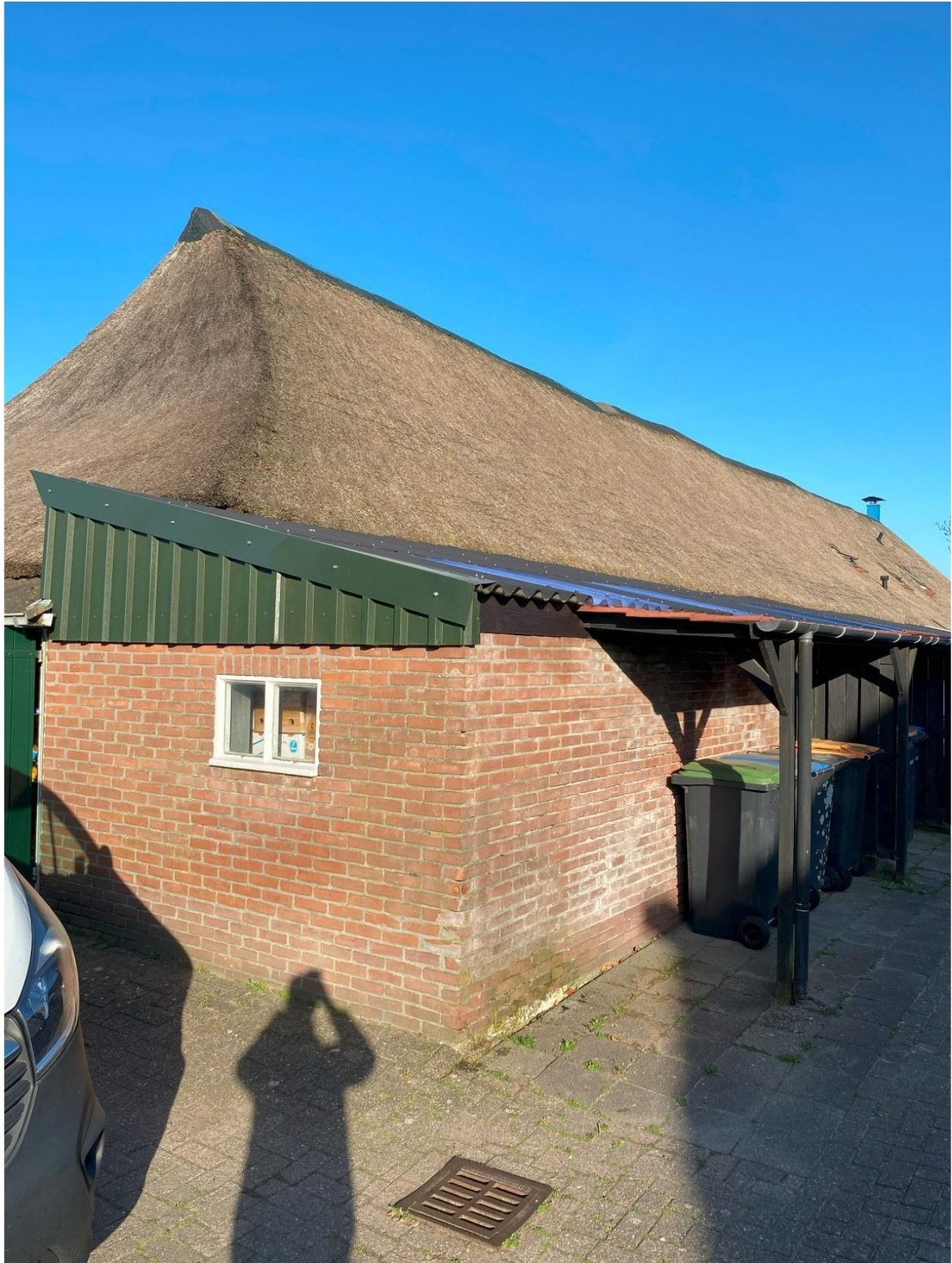
Aanbouw linker gevel
