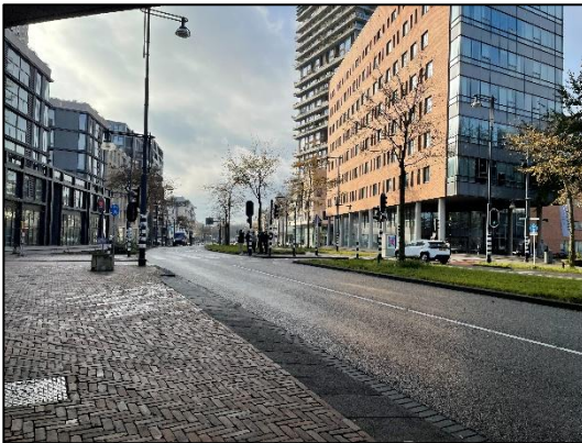
Foto 7. Radarweg (ten zuiden van de spoorbrug).
