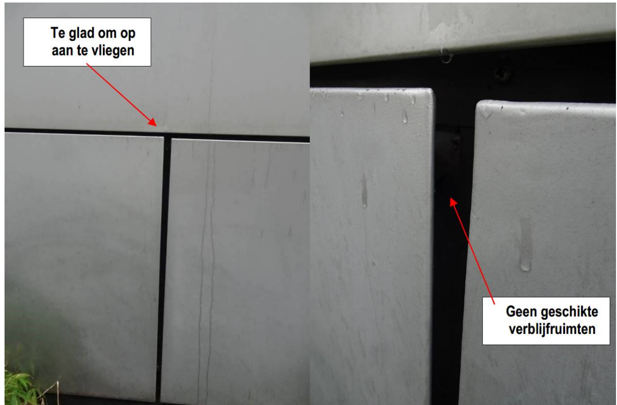
Figuur 5. Plaatmateriaal is te glad en er zijn geen geschikte verblijfplaatsen voor vleermuizen en daardoor is het pand aan de Paasheuvelweg 15 te Amsterdam ongeschikt als verblijfplaats voor vleermuizen.
