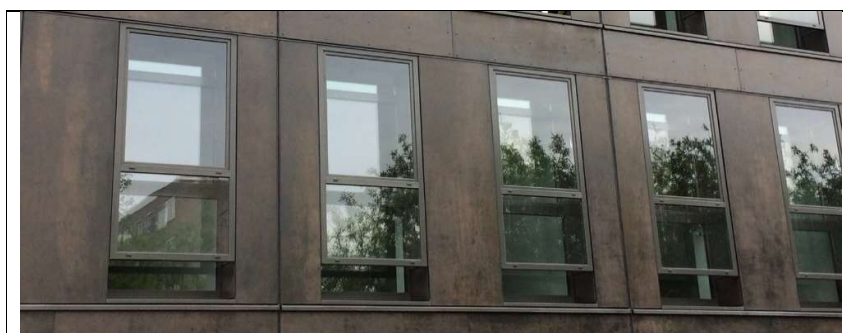
Figuur 6.5: Dubbelraamprincipe (project Laan van Spartaan/Westkavel) in Amsterdam
