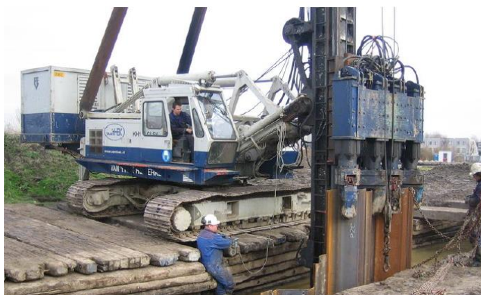
Foto 1 voorbeeld rupskraan met een Quattro piler
