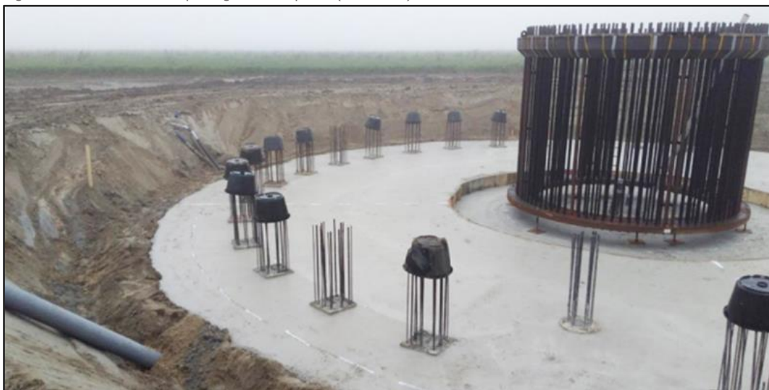
Figuur 3.2 Ankerkooi en wapeningsstaal heipalen (voorbeeld)
