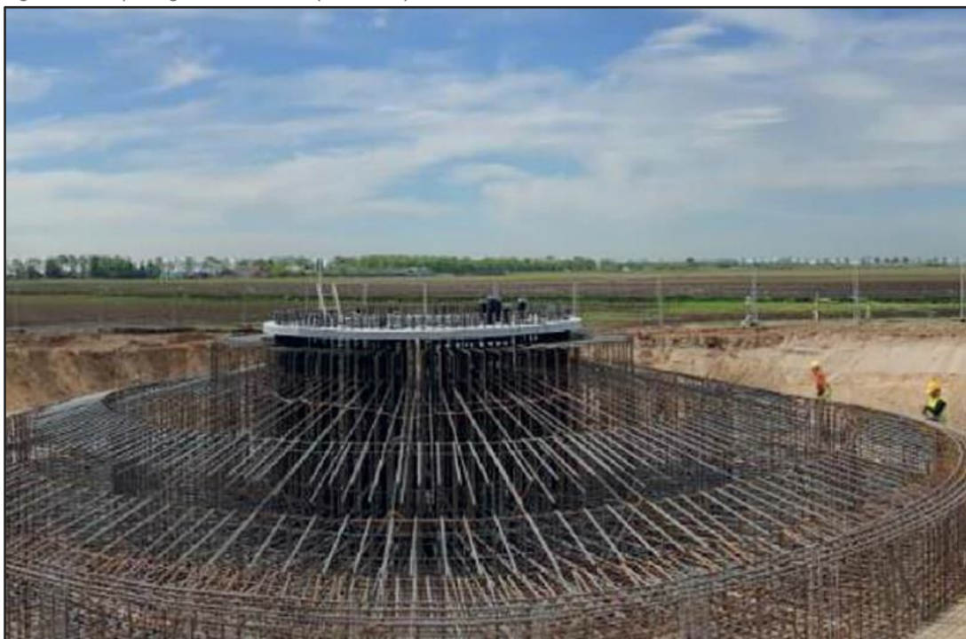
Figuur 3.3 Wapening van fundament (voorbeeld)
