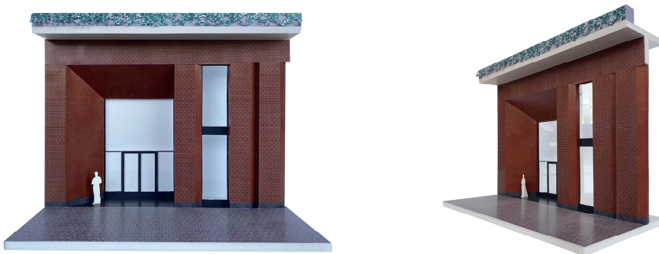
Figuur 24. Het afschuinen van de penanten komt op een grotere schaal terug bij de hoofdentrees.
