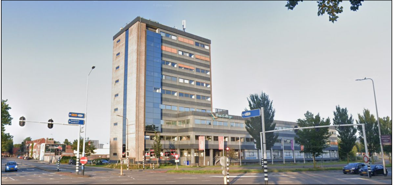
Figuur 2. Huidige situatie Schipholweg 1 (bron: Google Streetview, geraadpleegd 7 december 2021).
