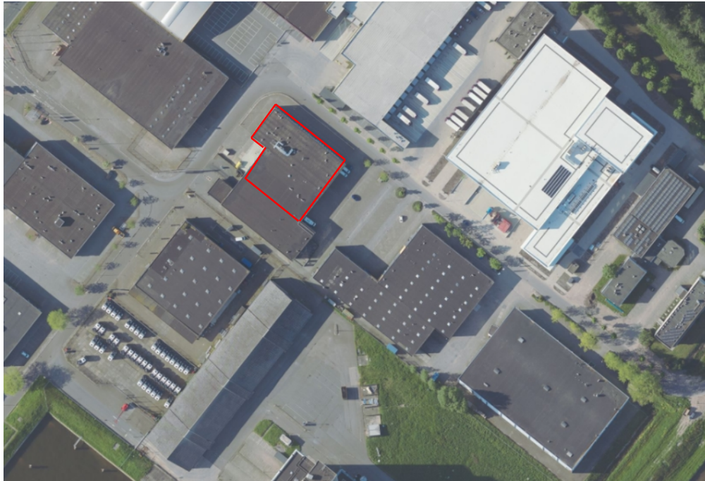
Figuur 2.1 Het bedrijfsgebouw van AHV is aangegeven met een rood kader. Bron: Streetsmart
