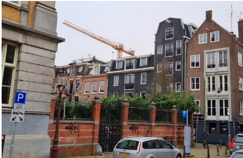
Figuur 4: Woningen Raamstraat
