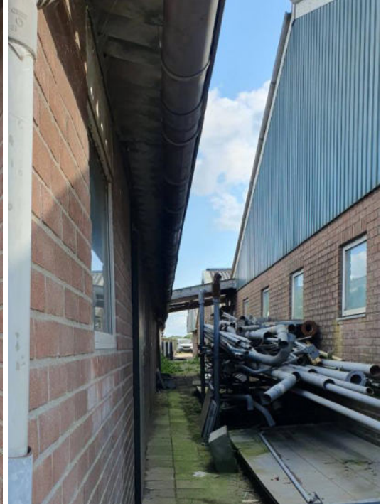
Foto 2: dakgoot westzijde gebouw 8 en 9
