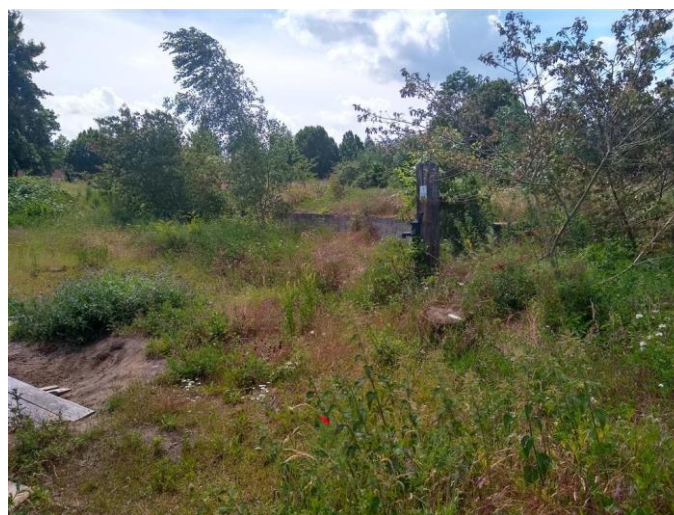
Foto 5 Betonwand noordelijk terrein
