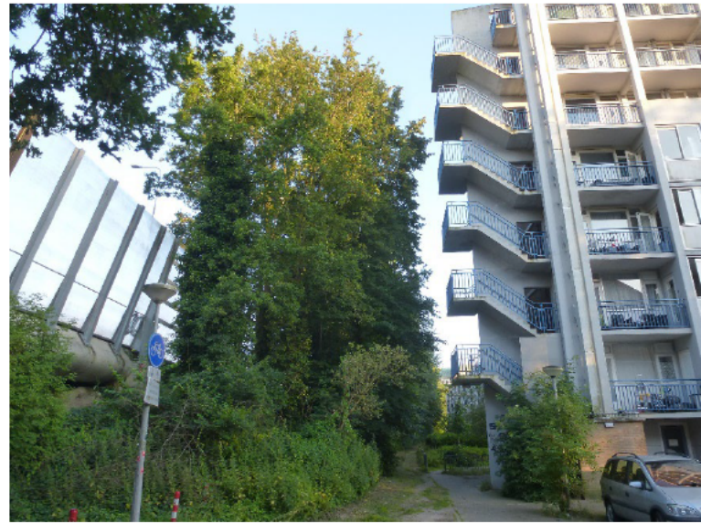
Figuur 2. Beeld van de flat Anton Waldorpstraat ter hoogte van het talud van de A10 en de fietsonderdoorgang.
