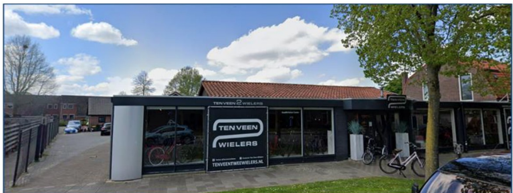
Figuur 6 : Op de voorgenomen bouwperceel staat momenteel bedrijfsbebouwing ten dienste van een (voormalige) fietswinkel. Deze bebouwing gaat gesloopt worden.
