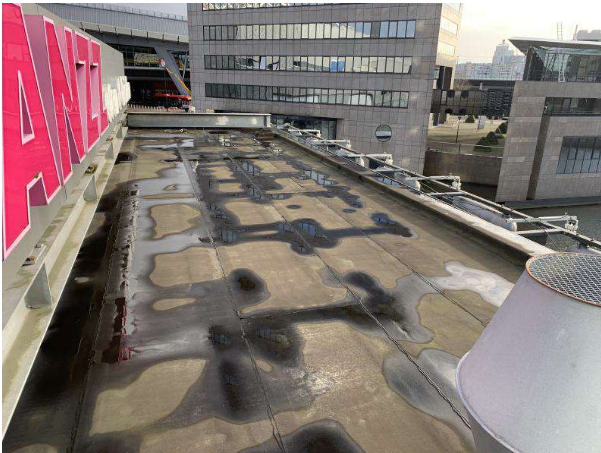
Het dak bestaat uit bitumen
