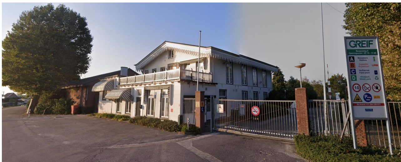
Figuur 38 Aanzicht van het monumentale kantoorgedeelte van de vestiging van Greif Nederland in Vreeland
