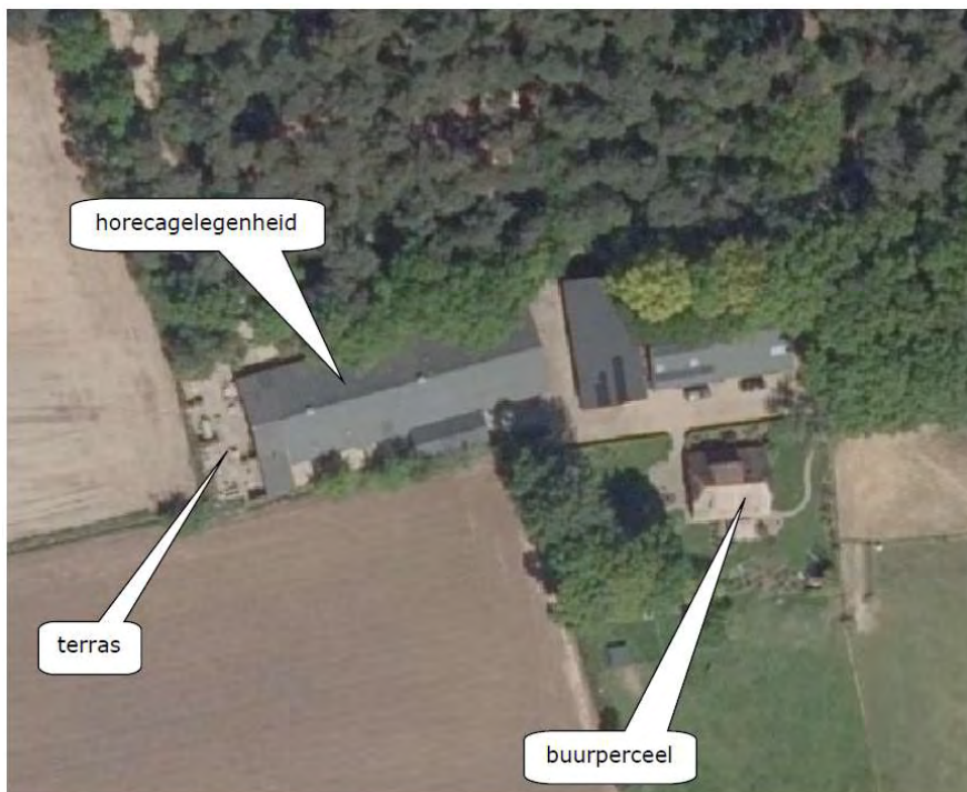
Figuur 2 Detail hoofdgebouw en buurperceel
