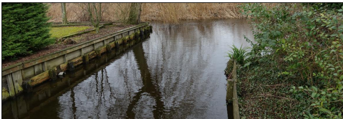
Figuur 14: De oevers van het perceel (rechts) hebben rechte houten beschoeiing die tekenen van verwerking begint te vertonen.
