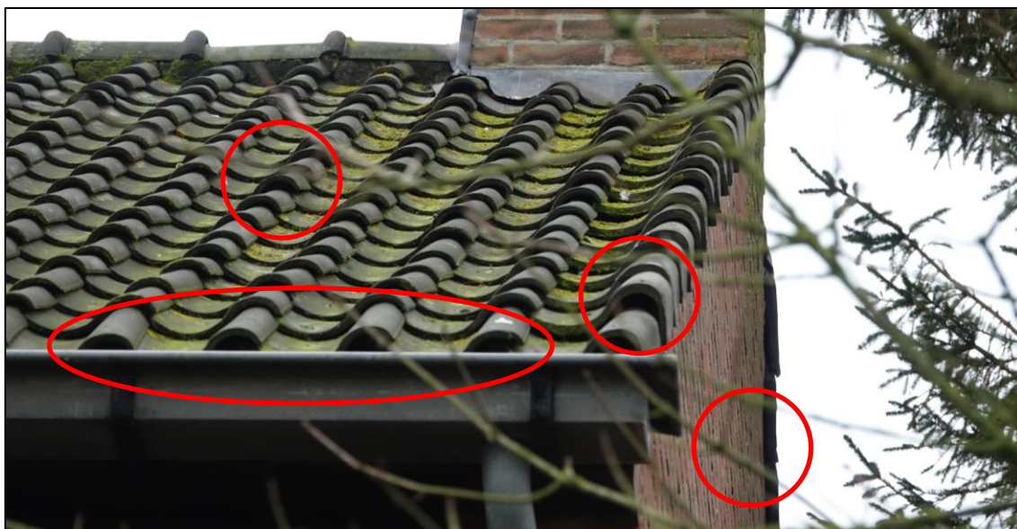
Figuur 10: Het dak van de twee onder één kap bevat veel wijkende dakpannen en beschikt over een toegankelijke dakrand waardoor gebouw bewonende soorten als de gierzwaluw en huismus een nest kunnen bouwen.
