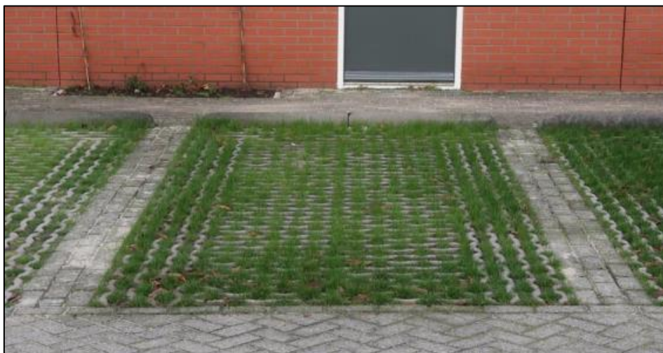
Figuur 9: Halfverharding bij parkeerplaatsen (bron:duurzaamdenhaag.nl).
