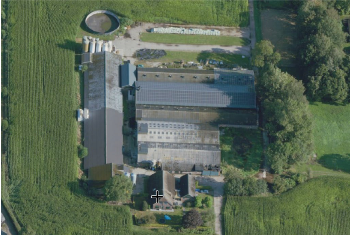
Afbeelding 3. Bouwlocatie Velnerweg 1 (Bron: Street Smart)
