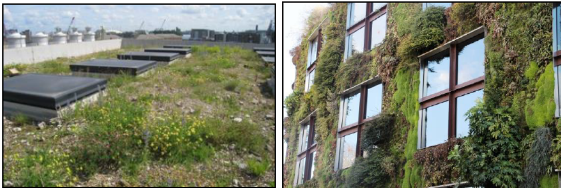
Figuur 8: Bruin dak (links bron: checklist groen bouwen) en groene gevel (rechts bron: groenkennisnet.nl).
