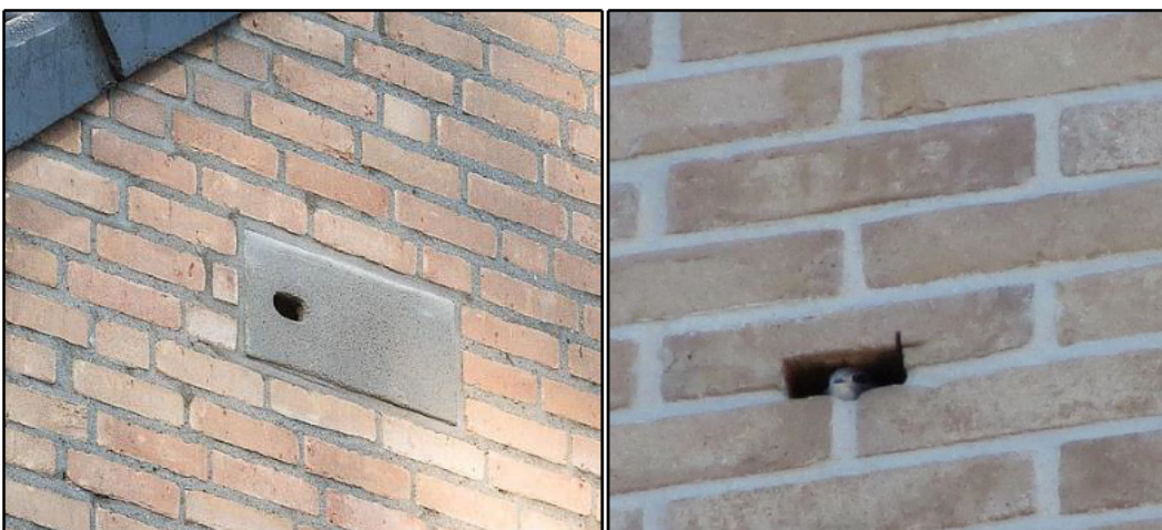
Figuur 4: InmetSELstenen zichtbaar (links) en onzichtbaar (rechts) in de gevel verwerkt (bron: Vivarapro).
