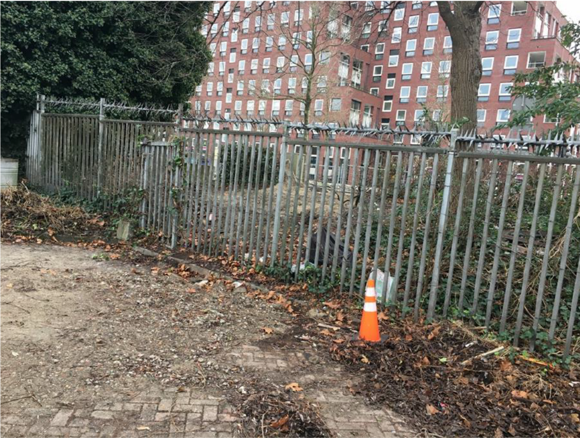
Foto 4: K&L-strook met hekwerk Food Center en groenstrook op talud
