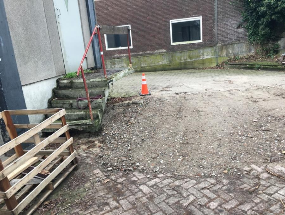
Foto 2: Inpandige traforuimte (links op de foto)
