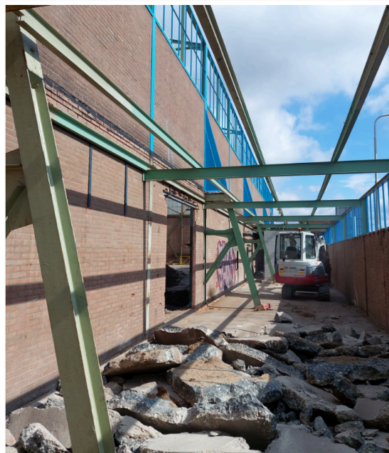
De binnengevel aan het binnenterrein is een bestaande opgaande metselwerk wand. Zie aanzicht hieronder.
