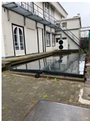
Figuur 11. Koelwaterbassin (N).
