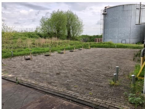
Figuur 28. Ondergrondse opslagtanks (3).
