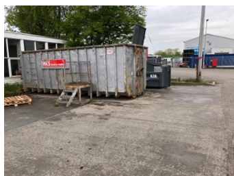
Figuur 39. Afvalverzamelplaats (16). Bodembedreigende stoffen.
