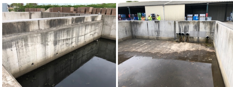
Figuur 33. Opvangbak bluswater (37).
