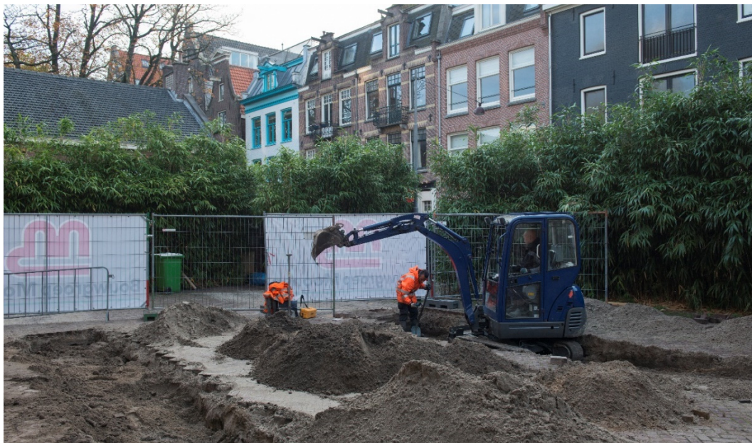
11 Aanleg van werkput 2, op de voorgrond de reeds aangevulde werkput 1, gezien vanaf het Raamplein richting de Raamstraat
