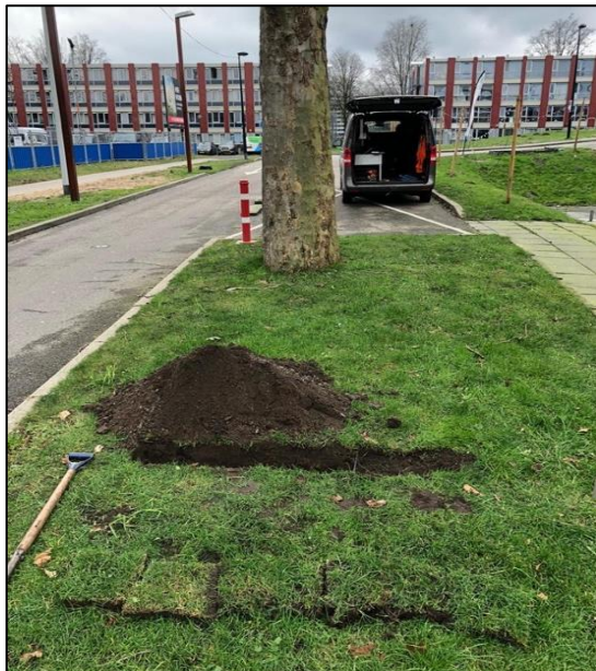
Foto 17: Tweede proefsleuf gegraven aan de achterzijde van de plataan in de grasstrook op 3 meter van de stamvoet. Aan het maaiveld zijn geen oppervlakkige wortels waargenomen van de boom.
