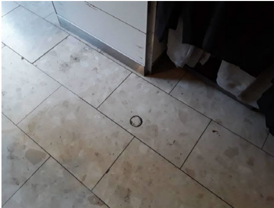
FB01: Alle boorgaten zijn na de werkzaamheden opgevuld met cement
