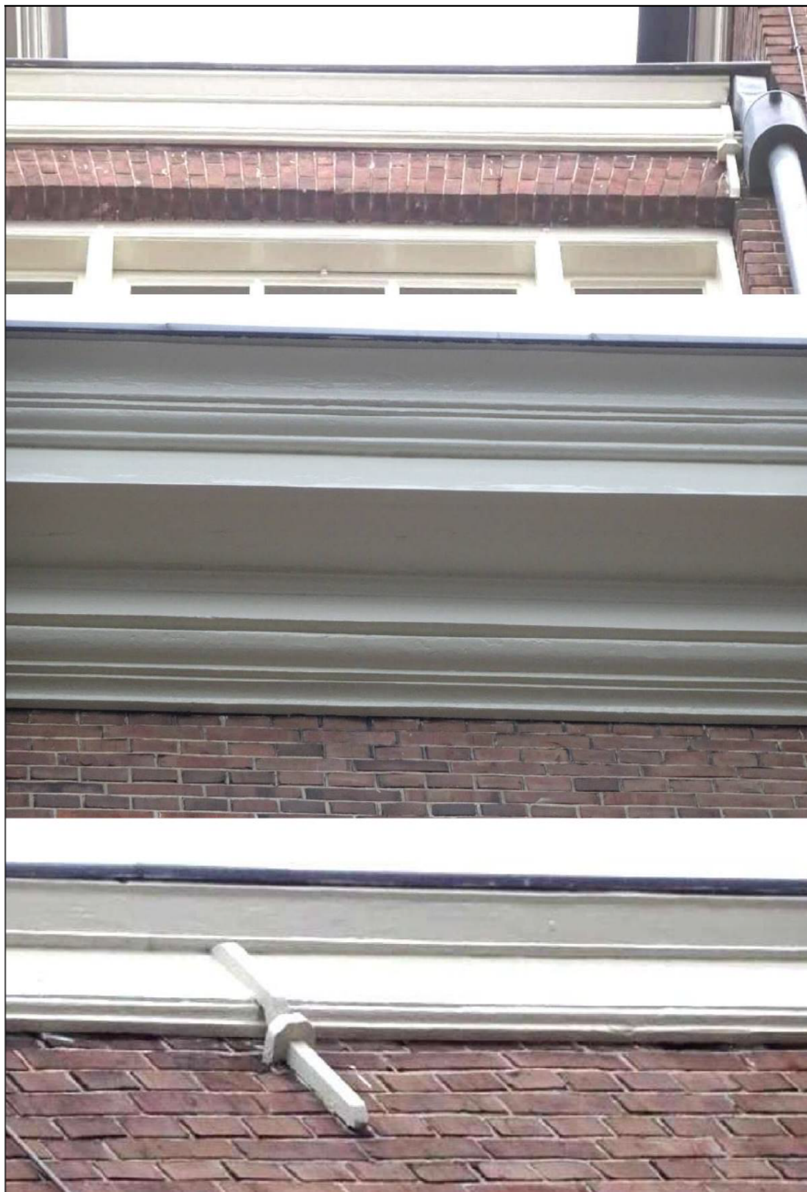
Figuur 4. De muren zijn volledig aangesloten op de dakranden / daklijsten in / grenzend aan het Raamplein 1 te Amsterdam en daardoor ongeschikt als verblijfplaats voor vleermuizen.
