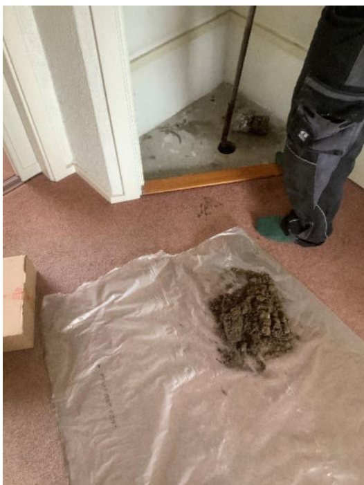
Opname inpandig boring (W102)
