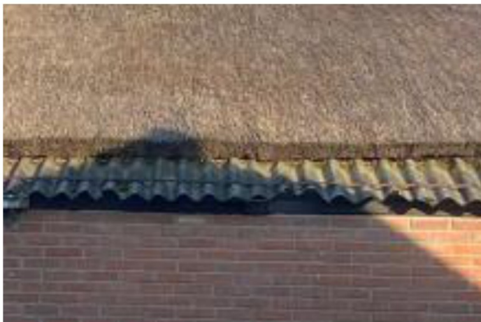
Golfplaten aan de onderzijde van het dak vervangen voor dakpannen. De grens van het riet wordt omhoog gehaald, zodat de dakpannen kunnen aansluiten met de dakpannen in de linker gevel.
