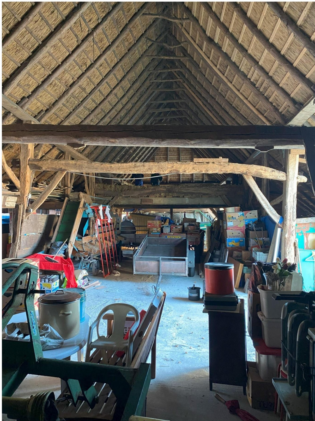
Binnenzijde achterhuis: De oorspronkelijke gebintconstructie en sporenkap
