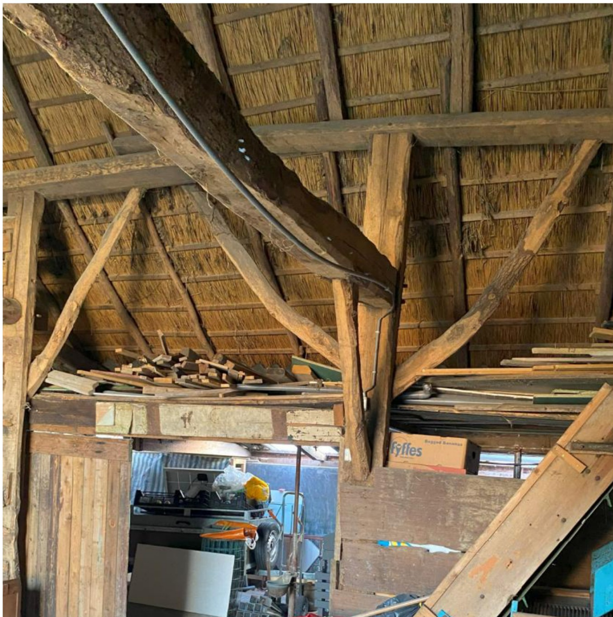
Bestaande gebintconstructie in combinatie met de schoren behouden en opnemen in de woning
