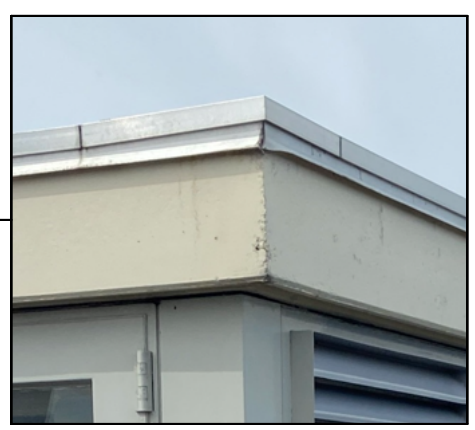
image huidige dakrandafwerking
