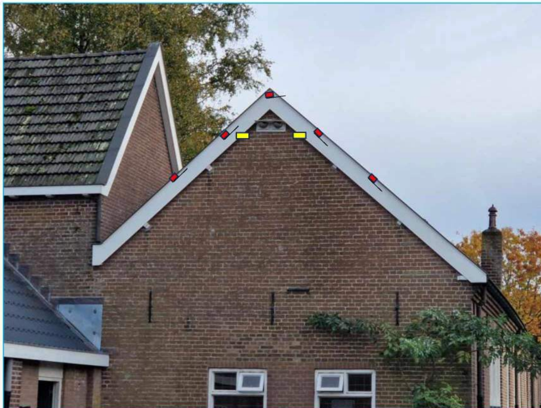
Foto: Aan te brengen openingen die toegang bieden naar de ruimte tussen dakpannen en beschot.
