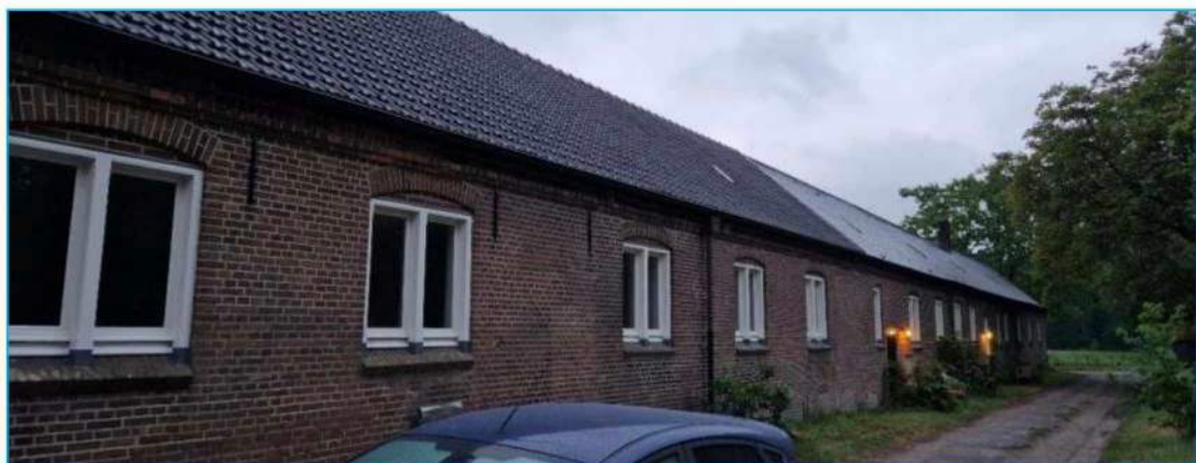
Foto: Links dakpannen oude deel, rechts dakleien gerenoveerde zuidelijke deel.
