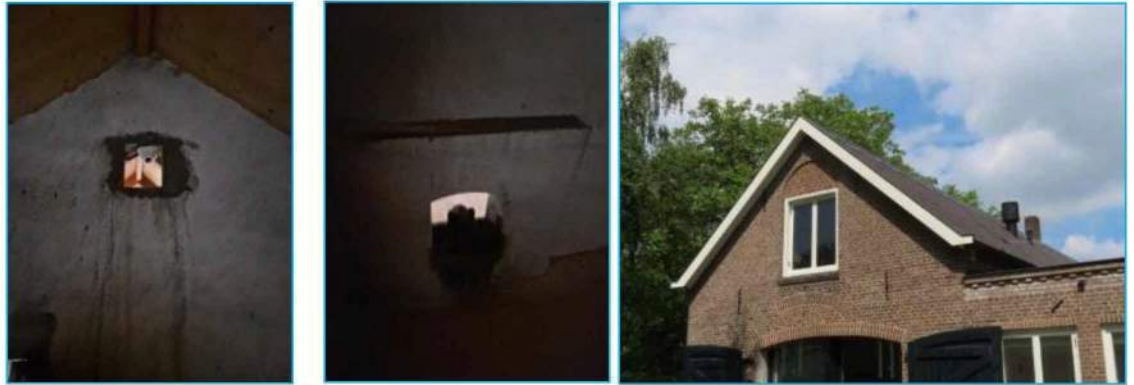
Foto's: De te dichten openingen in scheidingsmuren tussen vleermuisverblijven en wooneenheden en het et verduisteren raam.
