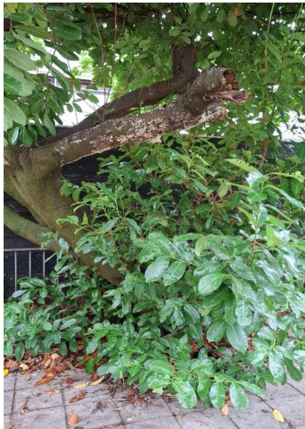
Foto 2. De laurierkers heeft eerder afgebroken tak die nu aan het rotten zijn
