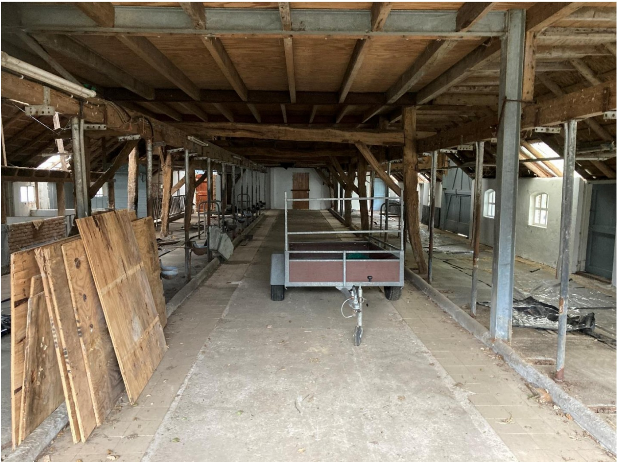
Fig. 7; Interieur stal: historische gebinten i.c.m. moderne stal met staalconstructie
