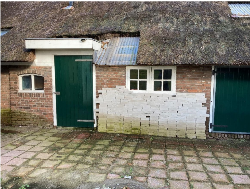
Fig. 54; eerste deel westgevel, gebikte stenen en nog verf van melkrek.
