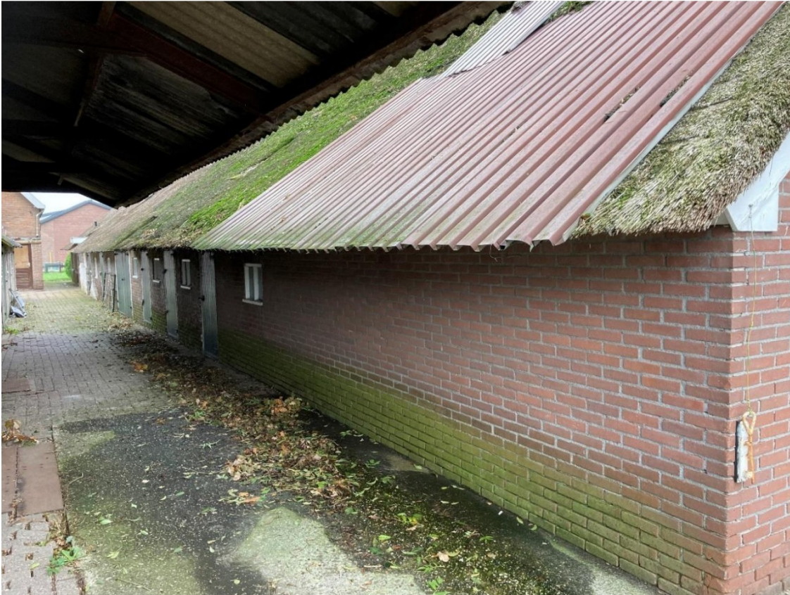
Fig. 57; laatste stuk gevelmetselwerk: Dit is het jongste stuk mw. (1990). Dak is deels afgedekt met een stalen dakplaat. Ook hier weinig historische elementen.
