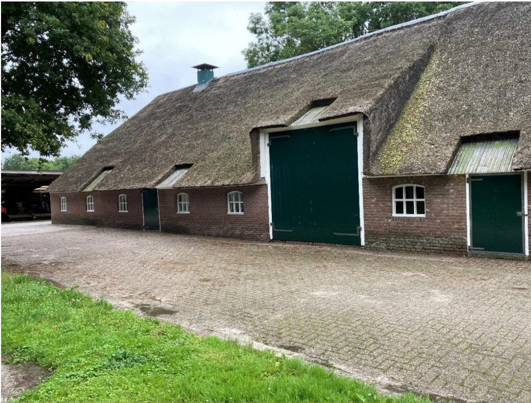
Fig. 52; Achter schuurdeur nieuw metselwerk.
