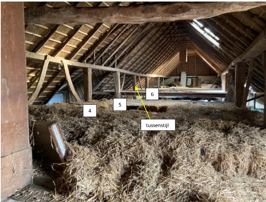
Fig. 21; gebintwerk en kasporen (gezien van voor naar achteren)
