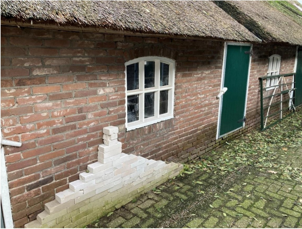
Fig. 56; 'derde' stuk metselwerk
