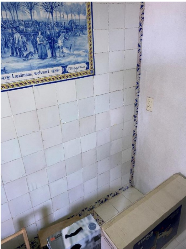
Fig. 42; linkerachterhoek woonkamer; lijst met stertegels deels afgedekt door voorzetwand. Onder langs kastenplint wel doorlopende plinttegels. Plint/lijst langs wand laat zien dat oude middenmuur direct achter voorzet wand is.
