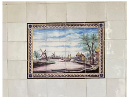
Fig. 39; afwijkend tableau; verschoven naad.
