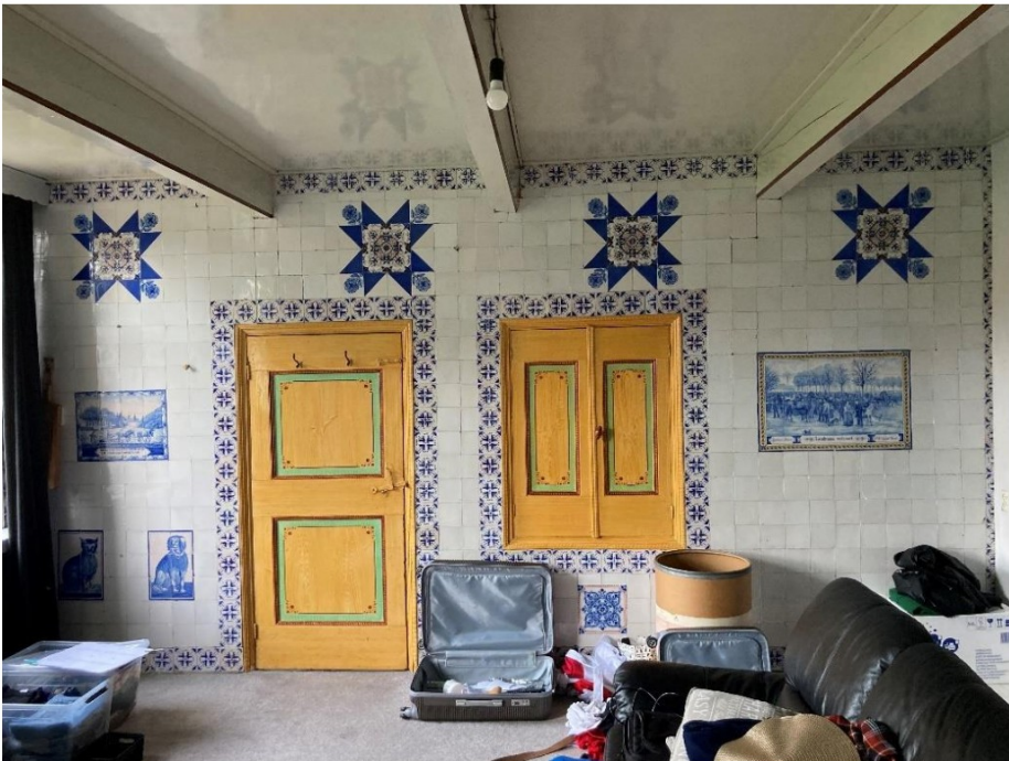
Fig. 4; zijwand woonkamer oost
