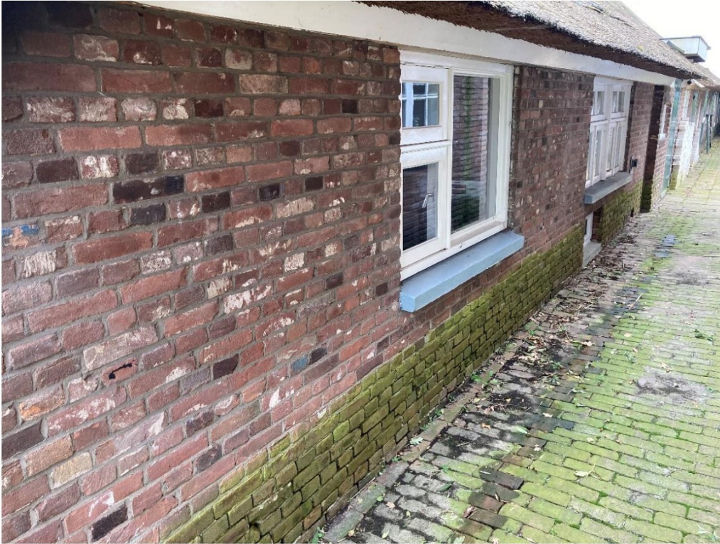
Fig. 54; eerste deel westgevel, gebikte stenen en nog verf van melkrek.
