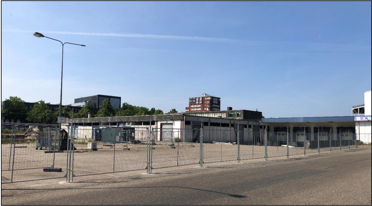
Afbeelding: de niet meer in gebruik zijnde bedrijfsgebouwen ter hoogte van de projectlocatie
