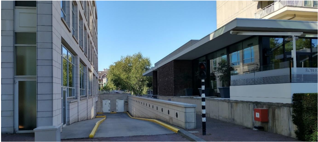
Inrit parkeergarage onder in de jaren negentig gerealiseerd kantoorgebouw (links) ten westen van het Hilton Hotel.
