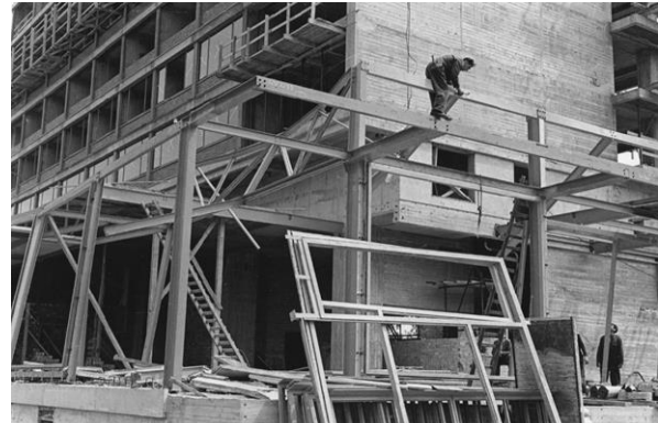
De onderbouw is onder het beddenhuis geschoven en heeft een eenvoudige staalconstructie. Foto's uit 1961 (Stadsarchief Amsterdam, OSIM00005002636 en OSIM00005002626).
