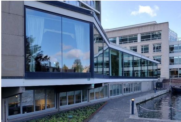
De puien van de onderbouw zijn in de loop der tijd vervangen, waarbij de ramen een extra verticale naad hebben gekregen. Ook de kozijnen van de kelder verdieping (links) zijn niet origineel.
