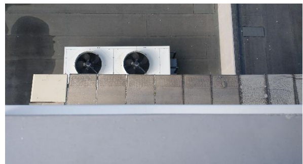
In de loop der tijd zijn de mozaïektegels rondom de kolommen op de balkons en diverse afdektegels op de betonnen vloerbanden vervangen. Op het balkon is de mozaïekafwerking van de zijwand (links) origineel, op de kolom is het vervangen. Op de foto van de afdektegels zijn de rechter tegels origineel. De andere typen zijn later aangebracht.
