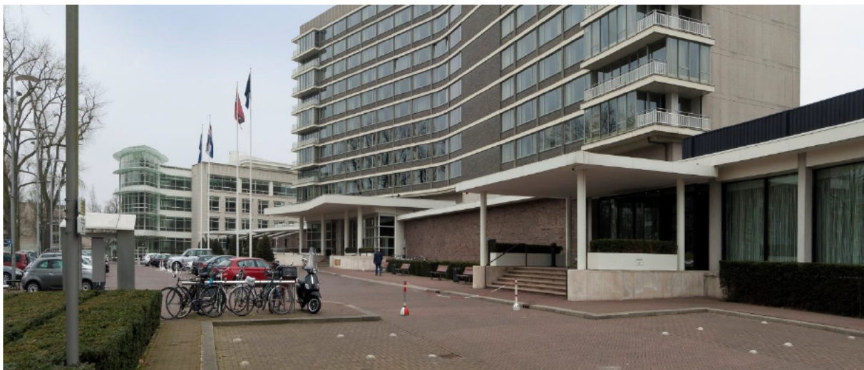
De luifel boven de entree van het conferentiecentrum is qua vormgeving familie van de luifel boven de hoofdentree. In eerste instantie was de luifel nog voorzien van zes rechthoekige sparingen met glas. Deze zijn in de jaren 2000 dichtgezet (Beeldbank Rijksdienst voor het Cultureel Erfgoed).
