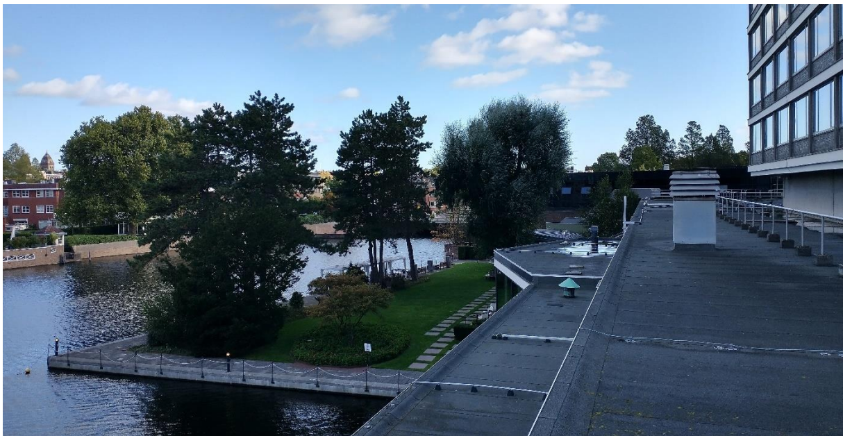
Het dakvlak langs de haven volgt de hoogte van het dak aan de zuidzijde en is daarmee lager dan het dakvlak rondom het beddenhuis. De afrastering rechts begeleidt de vluchtroute vanuit het westelijke noodtrappenhuis in het beddenhuis.
