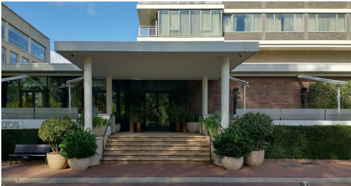
In vormgeving is de luifel bij de entree van het restaurant familie van de overige twee luifels.
