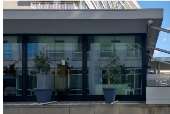
De puien van de onderbouw zijn in de loop der tijd vervangen, waarbij de ramen een extra verticale naad hebben gekregen. Ook de kozijnen van de kelder verdieping (links) zijn niet origineel.
