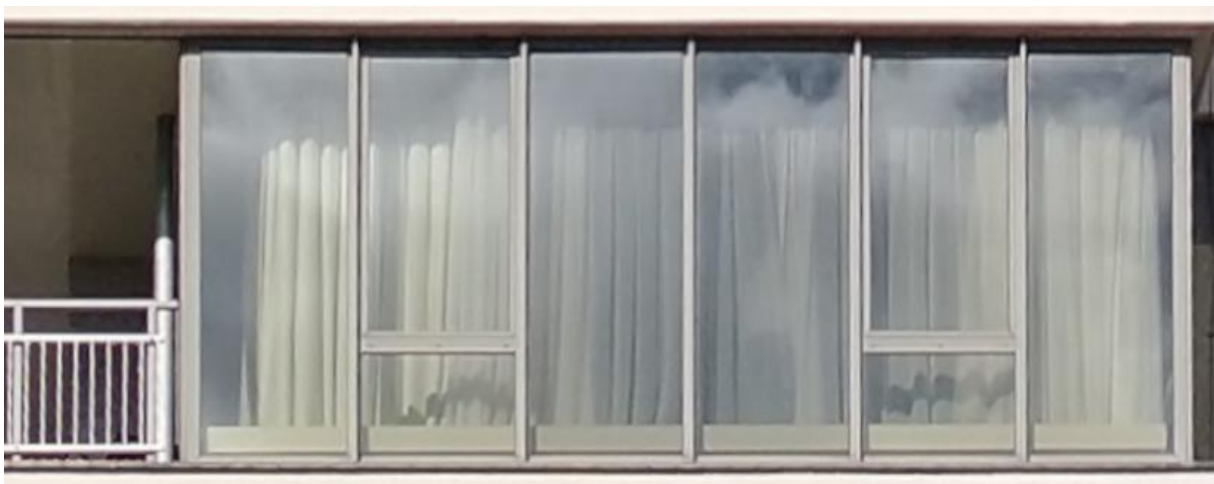
Oorspronkelijke stalen pui ter plaatse van het balkon aan de zuidwest zijde (boven, jaren zestig) en de huidige aluminium pui op dezelfde plek (onder). Bij de vernieuwing kregen de verdiepingshoge kozijnen aan de buitenzijde een verjonging. Bij alle vervangen puien is de kozijnindeling gehandhaafd (Stadsarchief Amsterdam, AANB0592800001).
