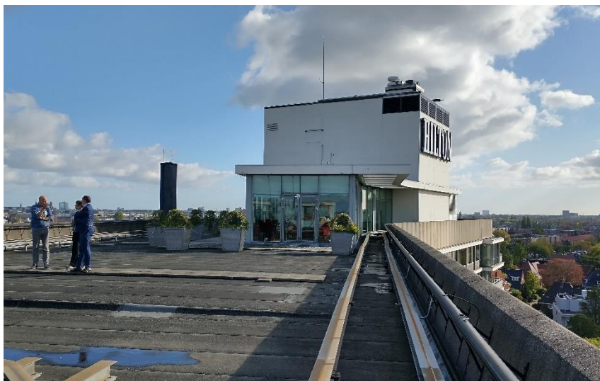
Rondom het dak van het beddenhuis loopt een iets terugwijkende balustrade/dakrand van schokbeton met een ronde reling. Achter de dakrand bevindt zich het railsysteem van de glazenwasinstallatie.
