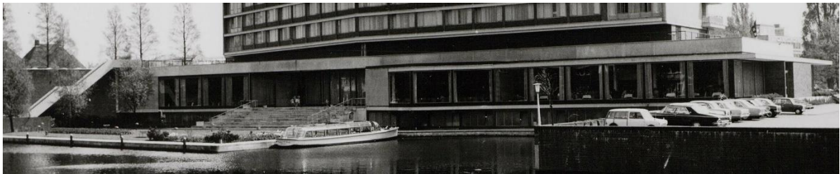
De Noordgevel bestaat grotendeels uit glas. De enkele gesloten geveldelen zijn bekleed met beige natuursteen. Foto uit 1969 (Stadsarchief Amsterdam, 010122002378).
