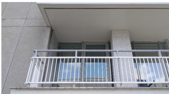
In de loop der tijd zijn de mozaïektegels rondom de kolommen op de balkons en diverse afdektegels op de betonnen vloerbanden vervangen. Op het balkon is de mozaïekafwerking van de zijwand (links) origineel, op de kolom is het vervangen. Op de foto van de afdektegels zijn de rechter tegels origineel. De andere typen zijn later aangebracht.
