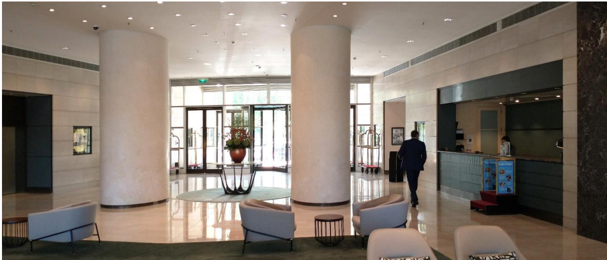
Vloer en wanden van de lobby kregen een afwerking in natuursteen. De kolommen zijn ovaal afgewerkt.
