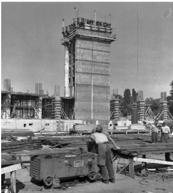
Nadat de liftkern middels een glijbekisting was gerealiseerd (links), werden de verdiepingen van het beddenhuis middels de boxframe-methode gebouwd (rechts). Foto's uit 1960 en 1961 (Stadsarchief Amsterdam, 911-5886 en Nationaal Archief, NL-HaNA_2.24.01.03_0_912-7647).
