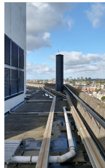
Rondom het dak van het beddenhuis loopt een iets terugwijkende balustrade/dakrand van schokbeton met een ronde reling. Achter de dakrand bevindt zich het railsysteem van de glazenwasinstallatie.
