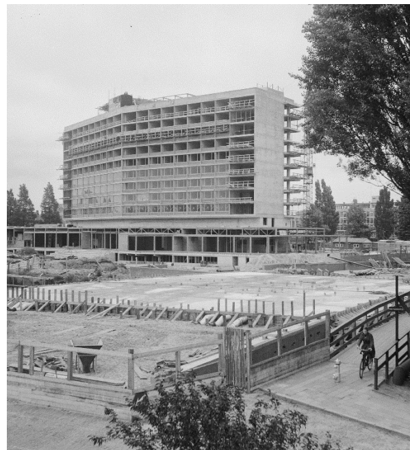
Nadat de liftkern middels een glijbekisting was gerealiseerd (links), werden de verdiepingen van het beddenhuis middels de boxframe-methode gebouwd (rechts). Foto's uit 1960 en 1961 (Stadsarchief Amsterdam, 911-5886 en Nationaal Archief, NL-HaNA_2.24.01.03_0_912-7647).
