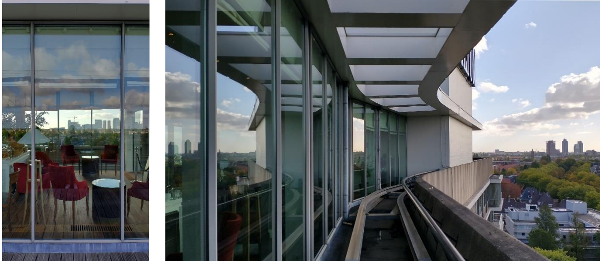
De luifel is voorzien van rechthoekige gaten en loopt voor de liftschacht langs.
