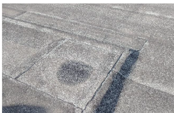
De constructief verzwaarde zone in het dak is zichtbaar als een iets hoger gelegen vlak in de bitumineuze dakbedekking.
