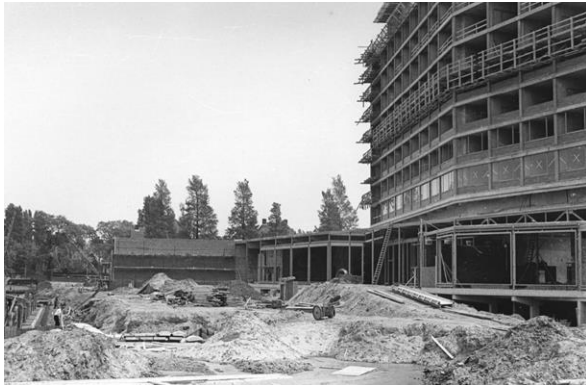
De onderbouw is onder het beddenhuis geschoven en heeft een eenvoudige staalconstructie. Foto's uit 1961 (Stadsarchief Amsterdam, OSIM00005002636 en OSIM00005002626).
