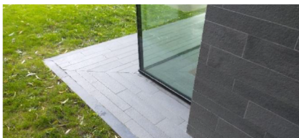
In de zuidgevel staan drie wanddelen die zijn bekleed met hardsteen. Het paviljoen is omzoomd door ditzelfde materiaal.
