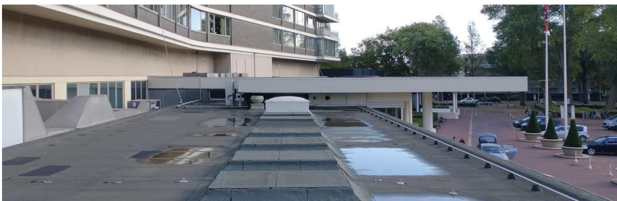
Dakvlakken van de onderbouw anno 2022. Daklichten zijn dichtgezet en het daglicht richting de inpannige ruimten onder het beddenhuis (linksonder) wordt geblokkeerd door installaties.
