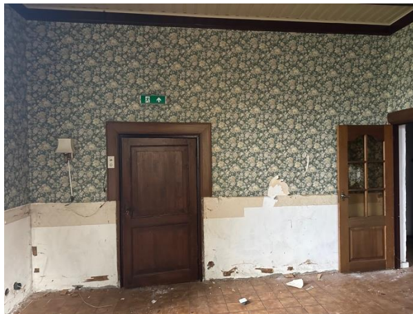
Wand richting gang 0.01
