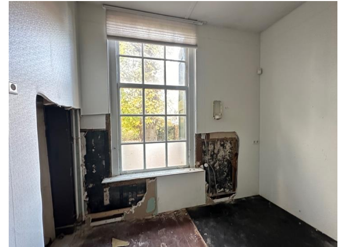
Buitengevel met huidige voorzetwanden gedeeltelijk verwijderd
