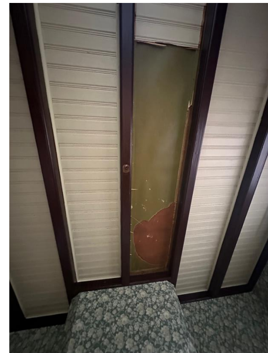
Huidig plafond (met huidige schrootjes plaatselijk verwijderd)
