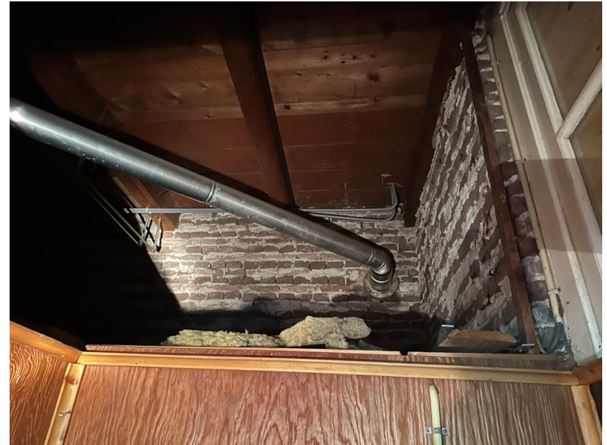
Plafond (boven huidige bestaande toiletgroep)
