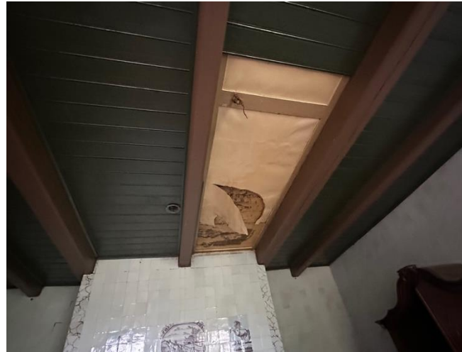
Plafond (schrootjes verwijderd)
