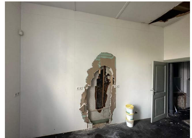
Buitengevel met huidige voorzetwanden gedeeltelijk verwijderd
