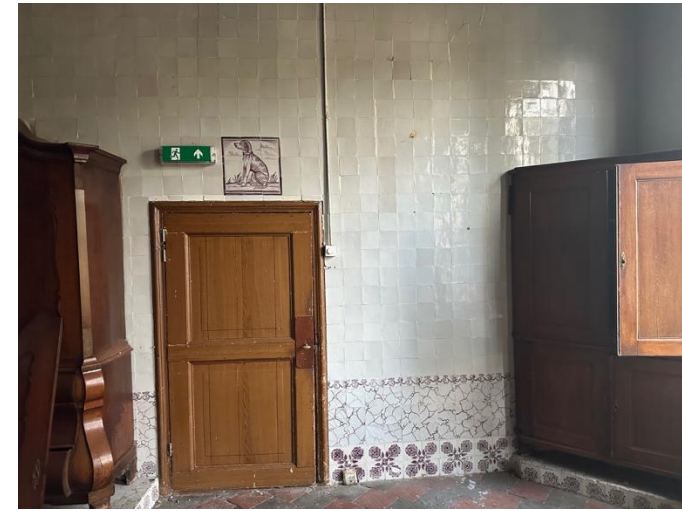
Wand richting gang 0.01
