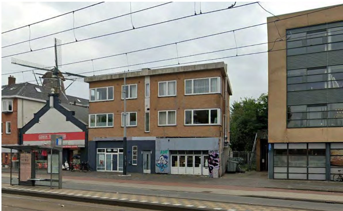
Afbeelding: huidige situatie projectlocatie
