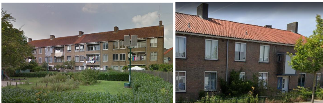
Afbeelding: impressie bestaande situatie (bron: Google earth)
