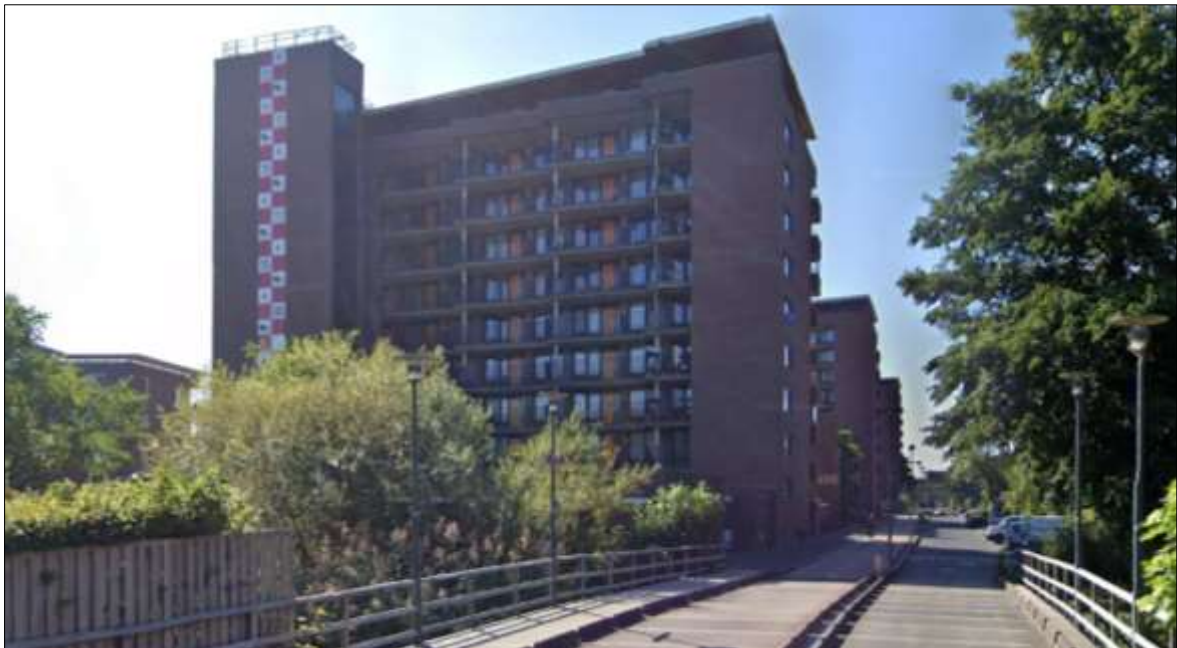
Afbeelding: woonblokken langs de Wembleyalaan, gezien vanaf de Sjaak Swartbrug (bron: https://www.google.nl/maps/ )
