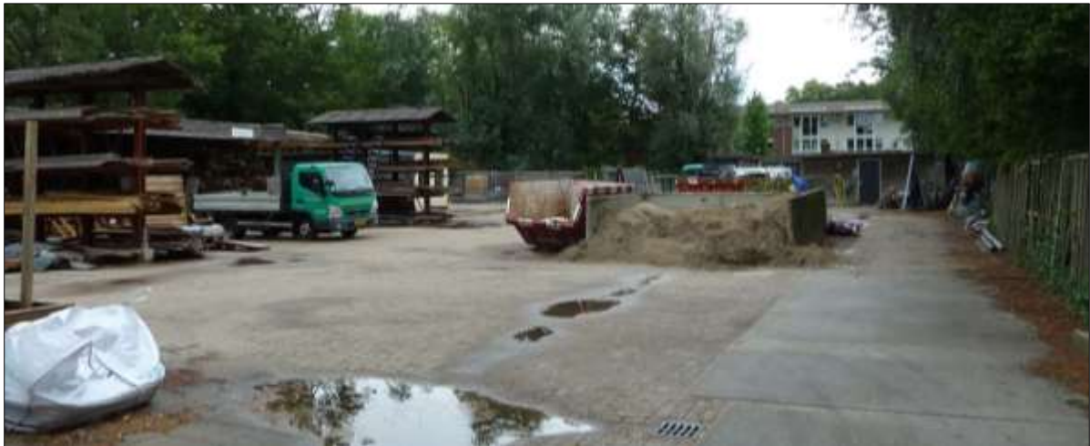
Afbeelding: opslag van materialen op de projectlocatie
