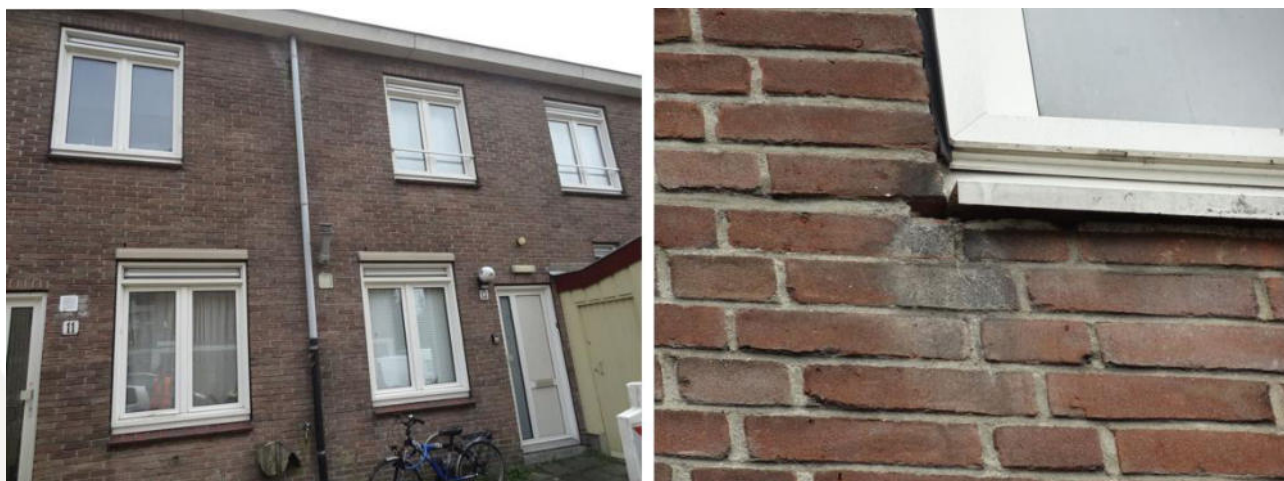
Figuur 5: Links, stootvoegen boven de ramen van de onderv verdieping in de rijtjeshuizen. Rechts, Opening bij een raamkozijn.
