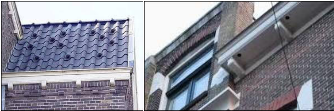
Figuur 8: Links: speciale pannen; rechts ruimte in de gootbetimmering.
