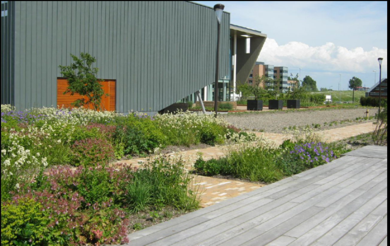
Figuur 11: Verblijfsdak op kelderdek (kantoor FifPro Hoofddorp)
