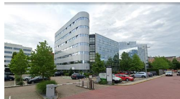
Figuur 2.2: Aanzicht gebouw vanuit noorden (bron: Google Streetview)
