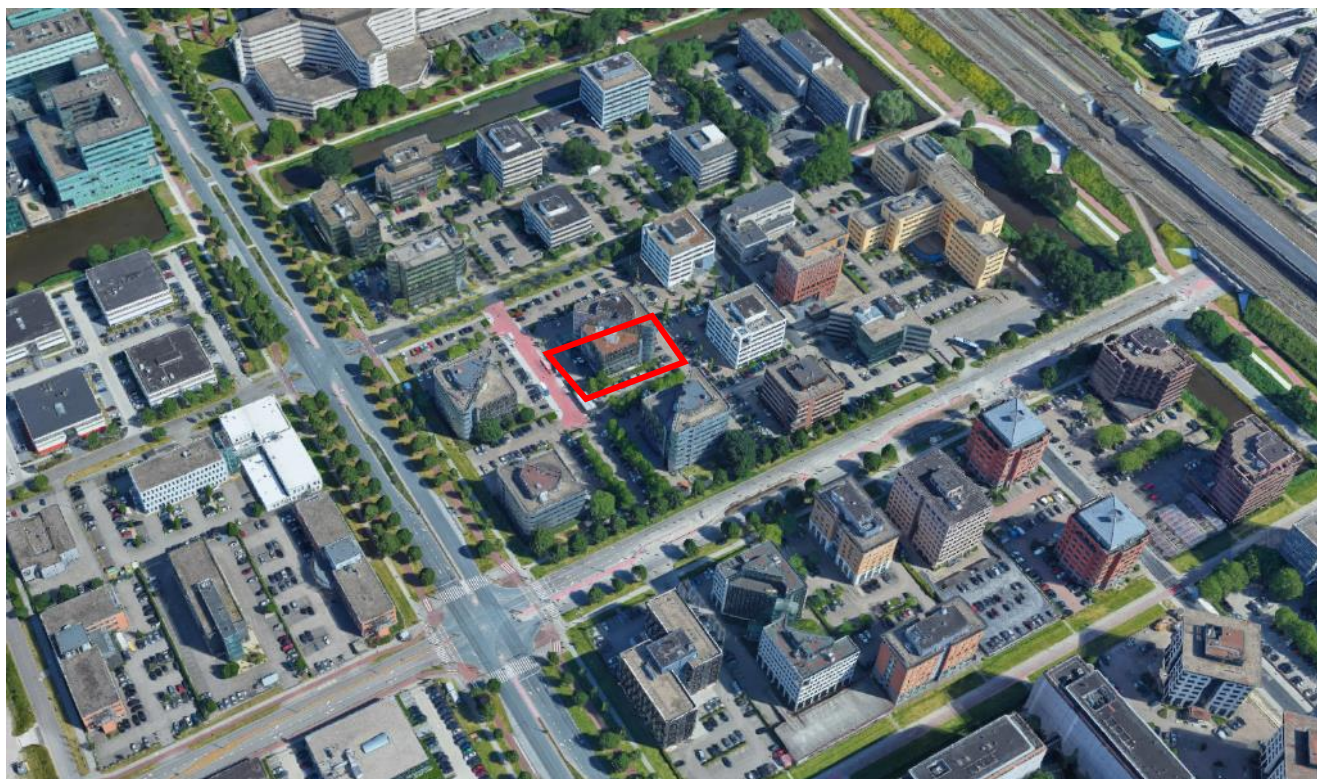
Figuur 2.1: Vogelvluhtaanzicht op plangebied in huidige situatie (vanuit zuiden) (bron: maps.google.nl)
