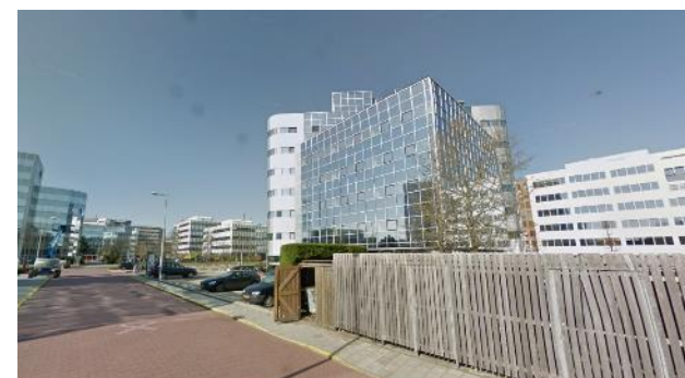
Figuur 2.3: Aanzicht gebouw vanuit zuiden (bron: Google Streetview)
