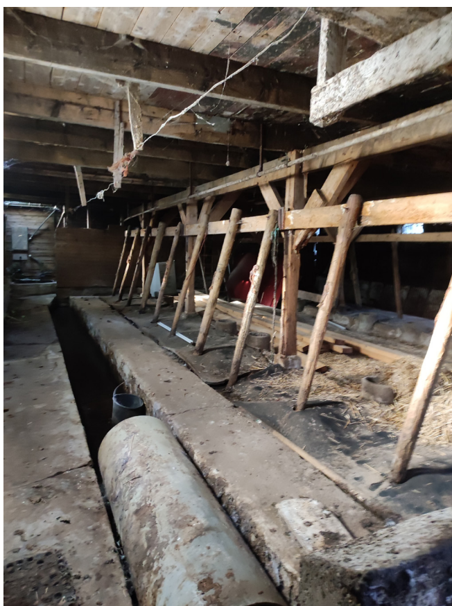
zicht op betonnen voergoot richting het woonhuis
