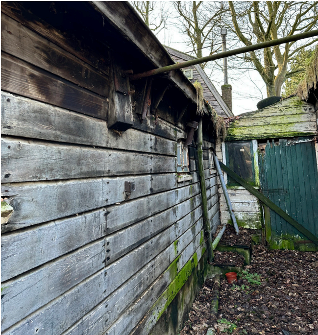
linker zijgevel stal met overdekte aansluiting op schuur
