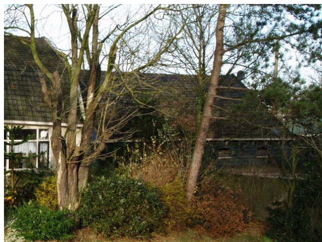
rechter zijgevel stal en woongebouw
