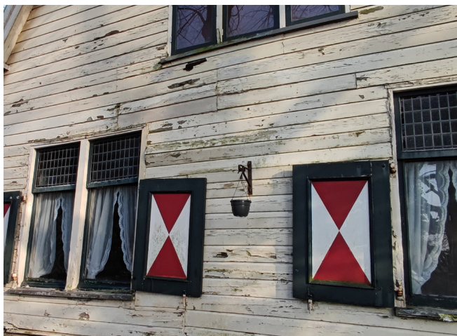
houtaantasting gevelbekleding en kozijnen
