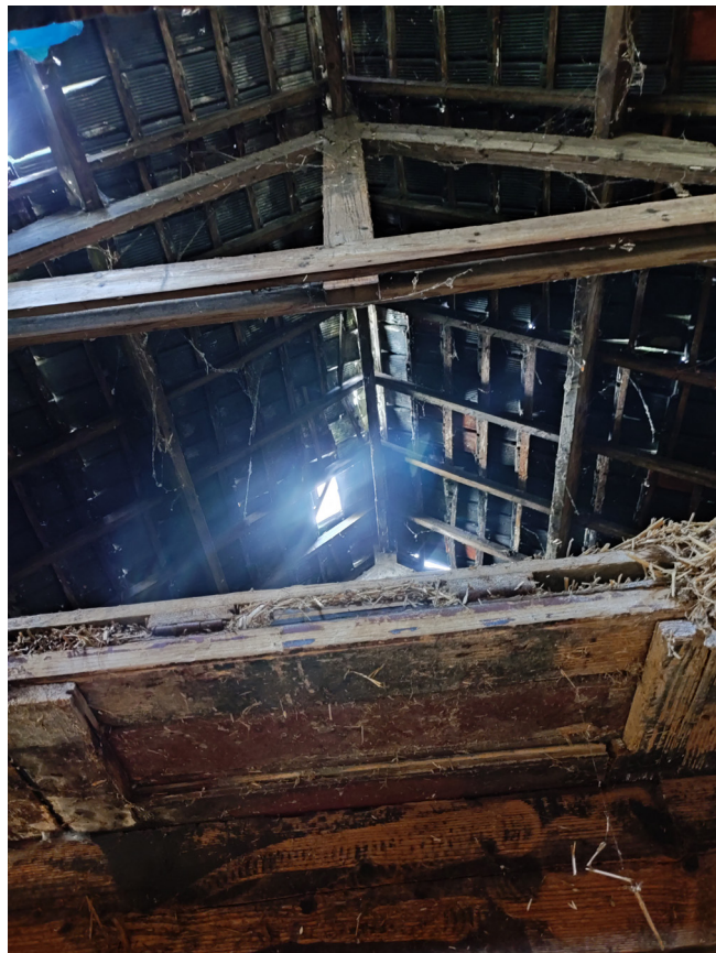
zicht op het plafond en de vloering
