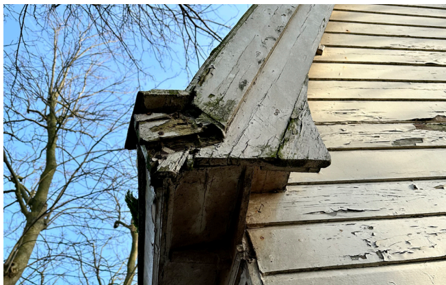
houtaantasting gevelbekleding en dakrand
