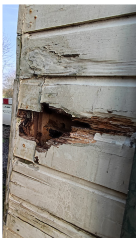
houtaantasting gevelbekleding
