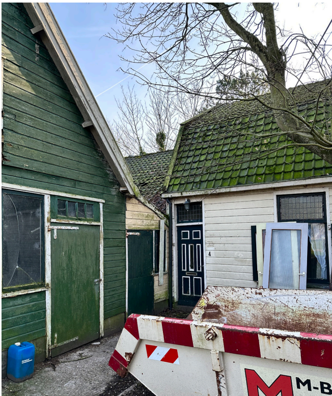
voorgevel schuur met overdekte doorgang naar de stal
