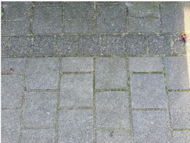
Foto van het straatwerk.
