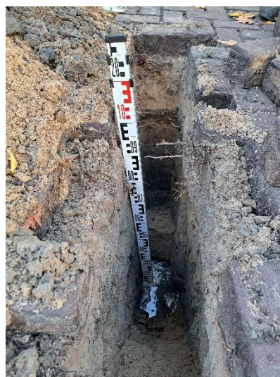
Afbeelding 14. Diepste meetpunt sleuf
