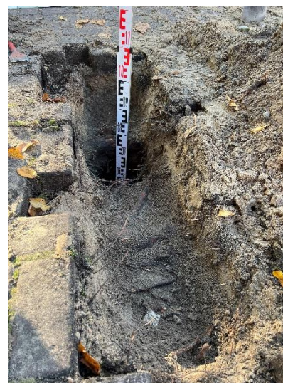
Afbeelding 17. Diepste meetpunt sleuf
