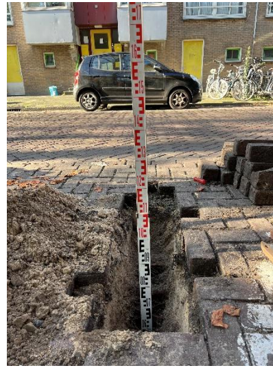
Afbeelding 22. Diepste meetpunt sleuf
