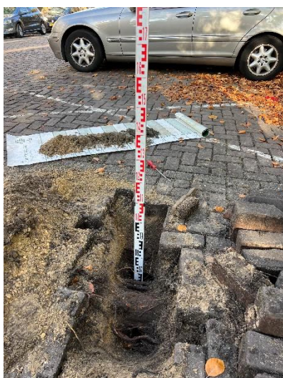
afbeelding 18. Diepste meetpunt sleuf
