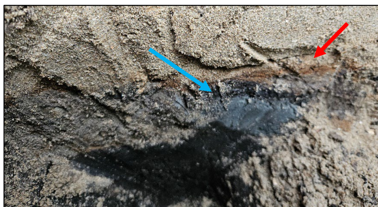
Figuur 13: Rode pijl toont de oxidatievlekken. De blauwe pijl toont de verdichte klei laag.
