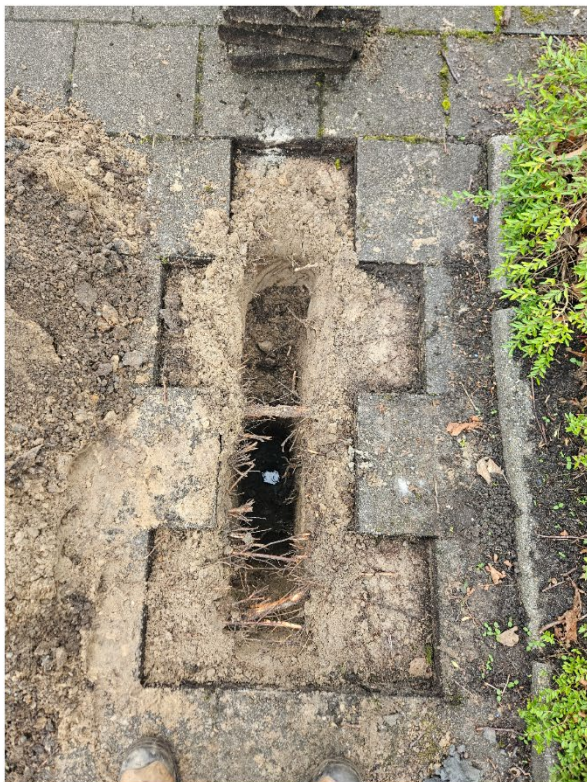
Figuur A: Overzichtsfoto profielsleuf boom 8.
