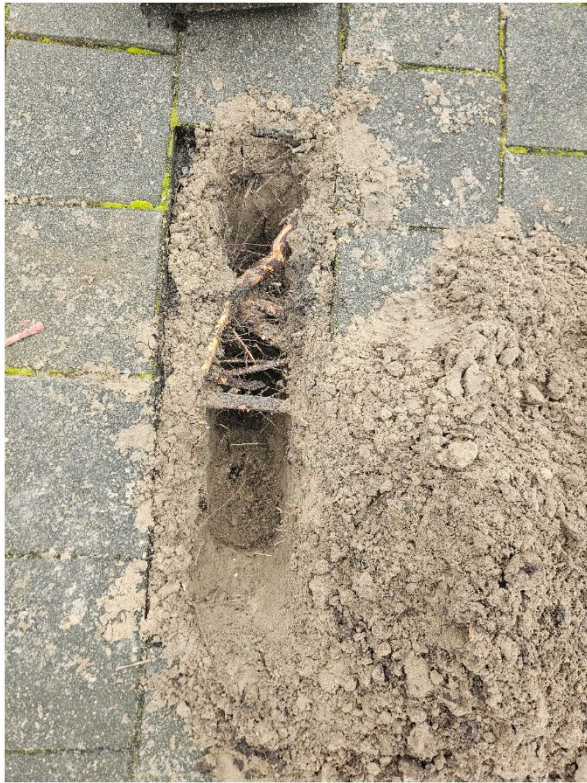
Figuur Q: Tegel opdruk door oppervlakkige wortels van boom 27.
