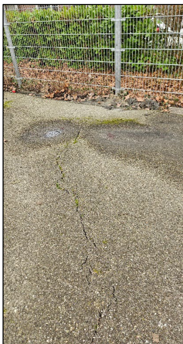
Figuur 27: Opdruk asfalt.
