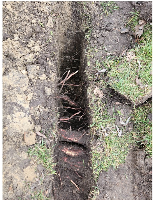
Figuur BB: Oppervlakkige wortels van boom 67.
