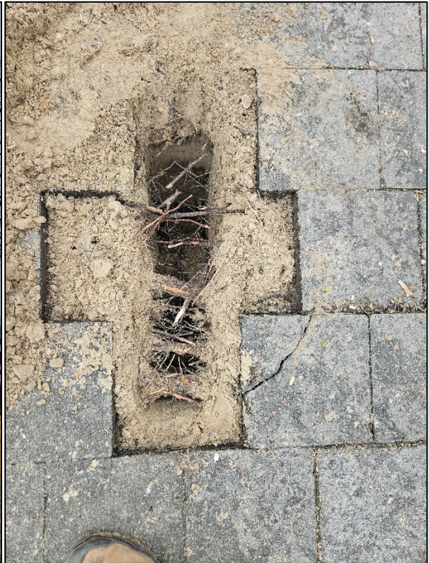
Figuur 15: Toont oppervlakkige wortels in profielsleuf 2.
