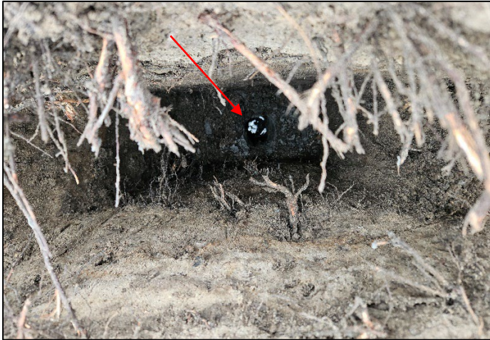
Figuur 9: Wortels boom 8 in de profielsleuf 1. De rode pijl toont het grondwater.
