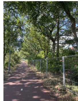
Afbeelding 20. Voorbeeld plaatsen vaste bouwhekken
