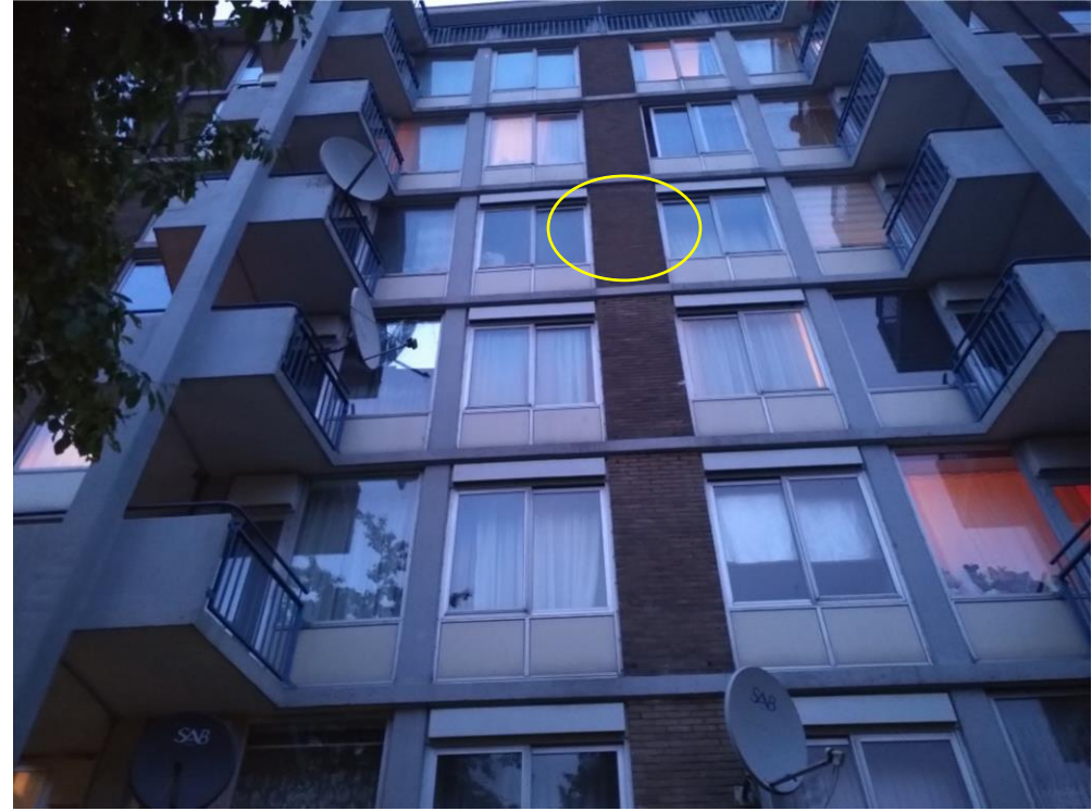
Afbeelding 12. Achtergevel Marius Bauerplantsoen – uitvliegende gewone dwergvleermuis, vierde verdieping.
